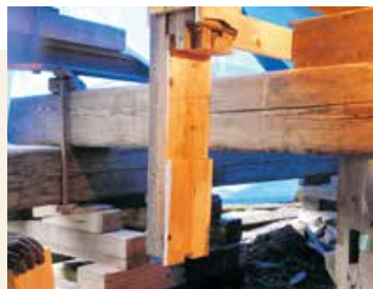
腐食した柱下部の部分的な補修工事
