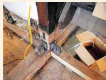
柱脚部の金物による耐震補強工事
