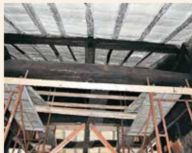
屋根垂木間への発泡系断熱材の吹き付けによる断熱性の向上工事
