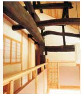
防火上主要な間仕切壁を設置
