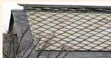
鉄平石で葺かれた屋根(松本市美術館)
