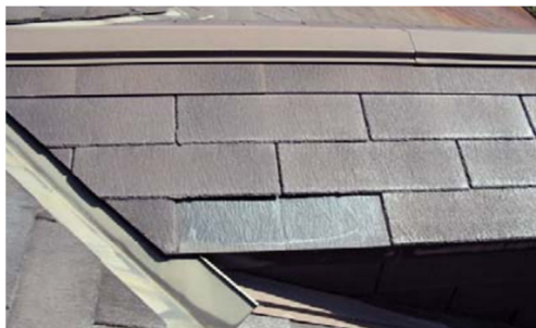
石綿含有住宅屋根用化粧スレート
