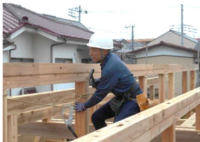
地域木造住宅の建設現場（出典：国土交通省）
