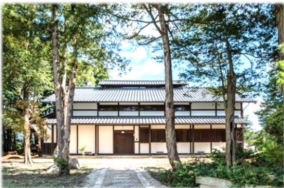
安曇野の民家再生 (令和7年度“信州の木”建築賞)
