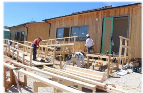
応急仮設住宅の建設（出典：国土交通省）
