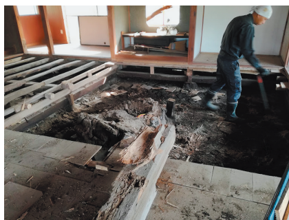
【自分達の手で改修工事を行う】
