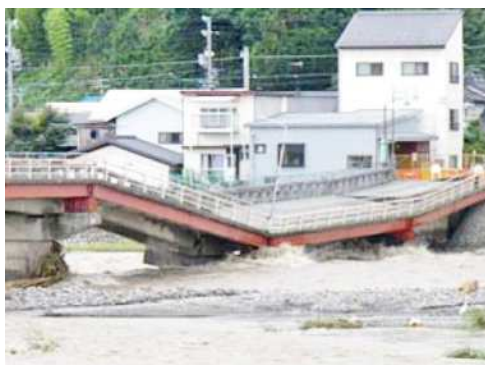
平成18年(2006年)7月豪雨 殿島橋の落橋(伊那市東春近・西春近) (天竜川上流河川事務所HP)
