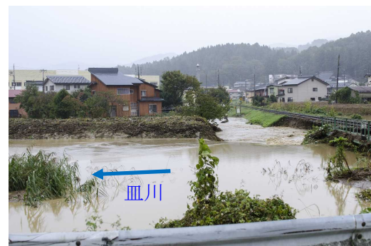
飯山市北町地先の破堤状況
