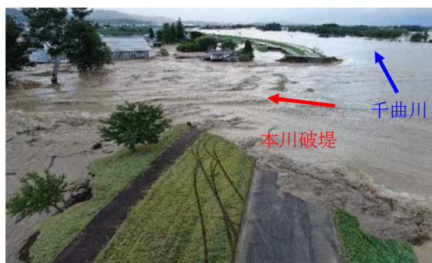
【令和元年 10 月洪水 千曲川本川決壊状況】 (長野市 穂保地先)
