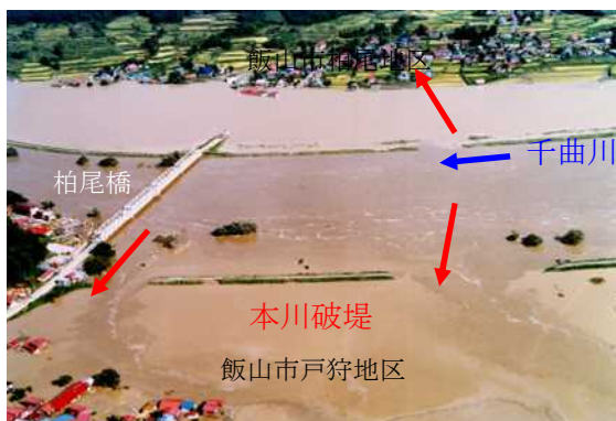
【昭和 58 年 9 月洪水 千曲川本川決壊状況】 (飯山市柏尾・戸狩地先)
