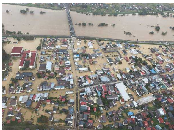
【令和元年 10 月洪水 飯山市街地浸水状況】
