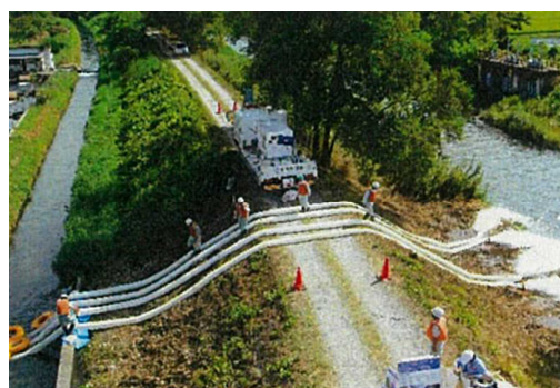
排水作業状況
