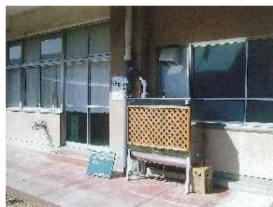
学校に設置されている雨水貯留タンク
