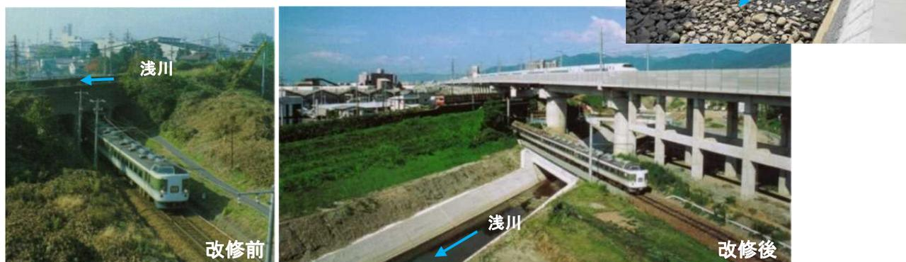
写真 2.6.1 天井川の解消状況
