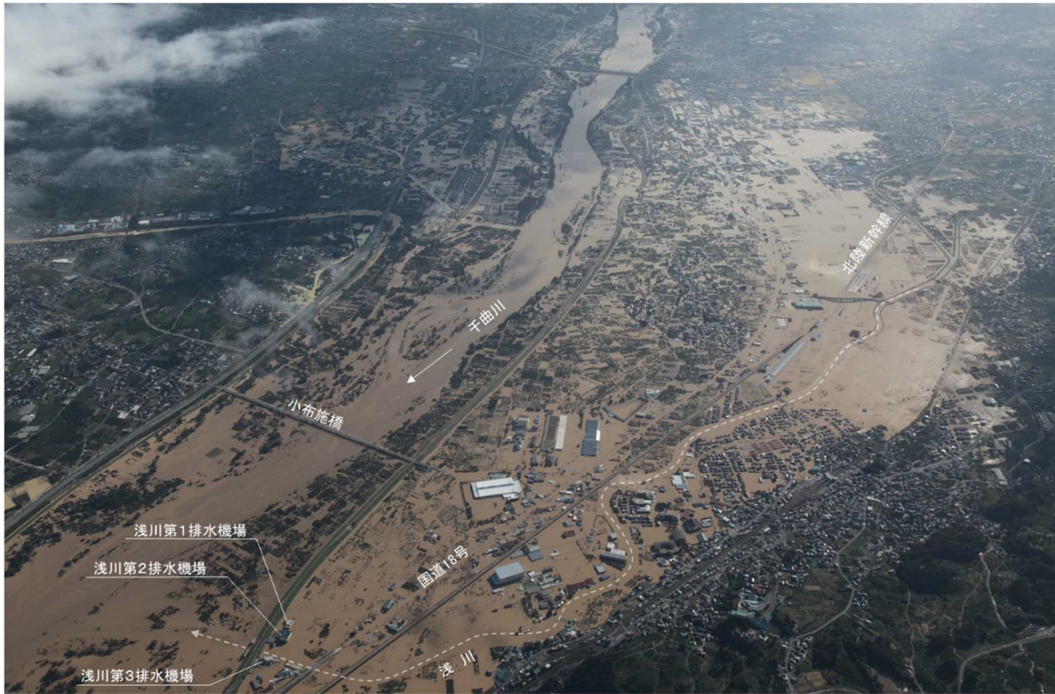
令和元年10月東日本台風（台風第19号）災害
