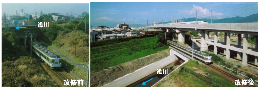
図 2.6.2 天井川の解消状況
