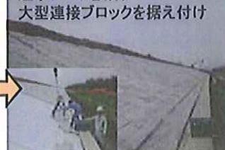
遮水シートを張り 大型接続ブロックを据え付け
