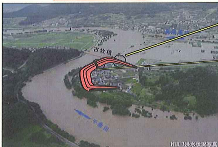
平成18年 7月出水の浸水状況
