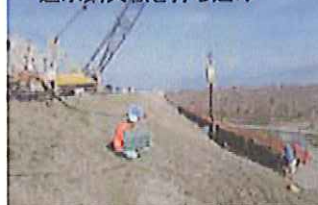
遮水鋼矢板を打ち込み
