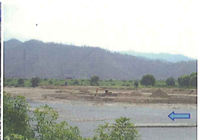
長野市岩野地先の河道掘削
