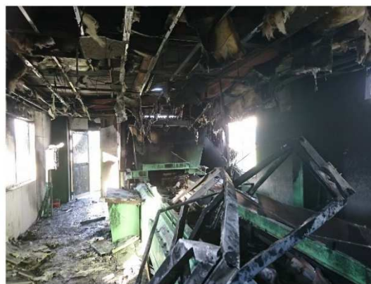
リチウムイオン電池の発火が原因で、リサイクル工場の建屋・設備が焼けてしまった事例
