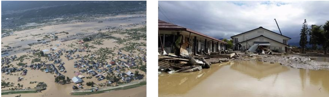
図46 令和元年東日本台風による洪水被害の状況
