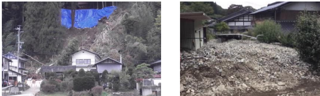
図 49 令和元年 10 月台風による土砂災害の状況
