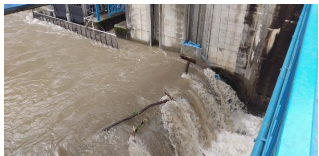
図 24 流木と濁度上昇時の取水口
