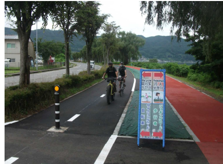
自転車の利用環境整備の例 (諏訪湖周サイクリングロード)
