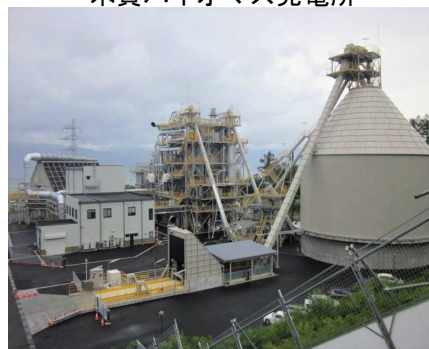
信州F・POWERプロジェクトの 木質バイオマス発電所
