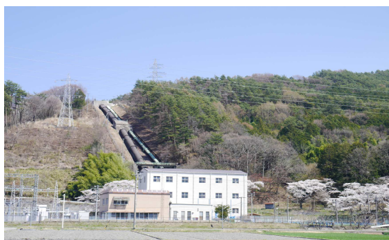
長野県企業局の春近水力発電所
