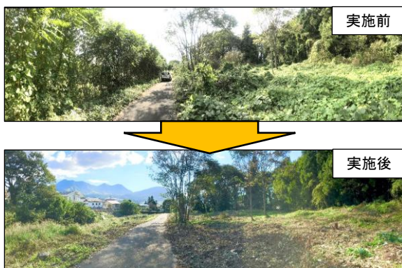
図11 クマの出没があった河川沿いのヤブの刈り払い（R6） （実施主体：県北信建設事務所、木島平村、地元地区）
