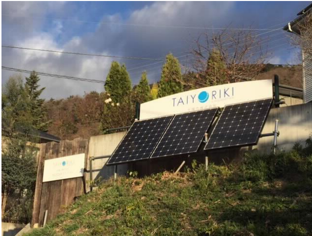
太陽光パネル3枚の独立型発電
