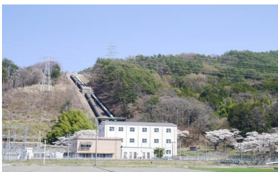
長野県企業局の春近水力発電所
