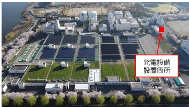
クリーンレイク諏訪 全景 （諏訪湖流域下水道豊田終末処理場）
