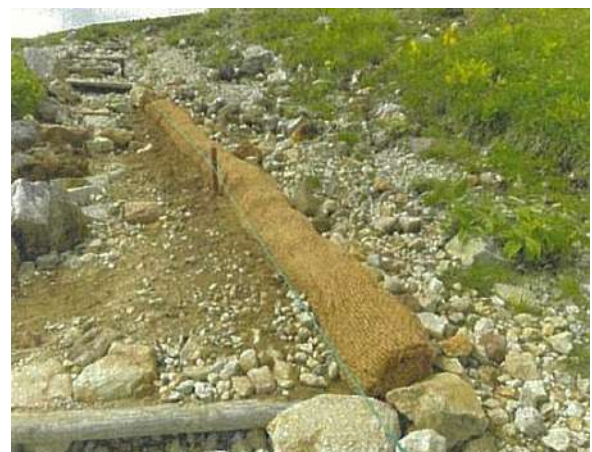
(一社)ネオアルプス 後立山連峰縦走線他 土留工
