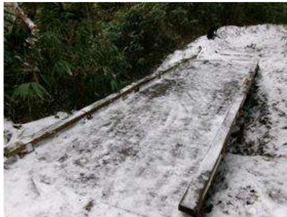
志賀山回遊線道路（歩道） 木道橋梁 （山ノ内町）
