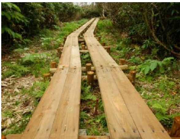
小谷村 柵池自然園木道整備補修
