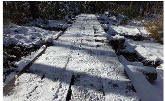
遊歩道木道再整備 (千曲市)
