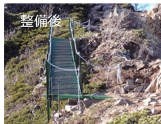
【老朽化した鋼橋と手すりを改修】
