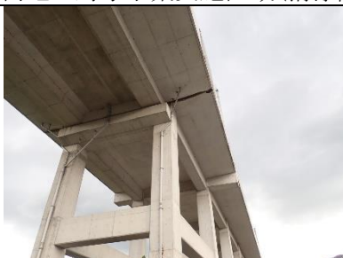
【市街地 新幹線高架橋】
