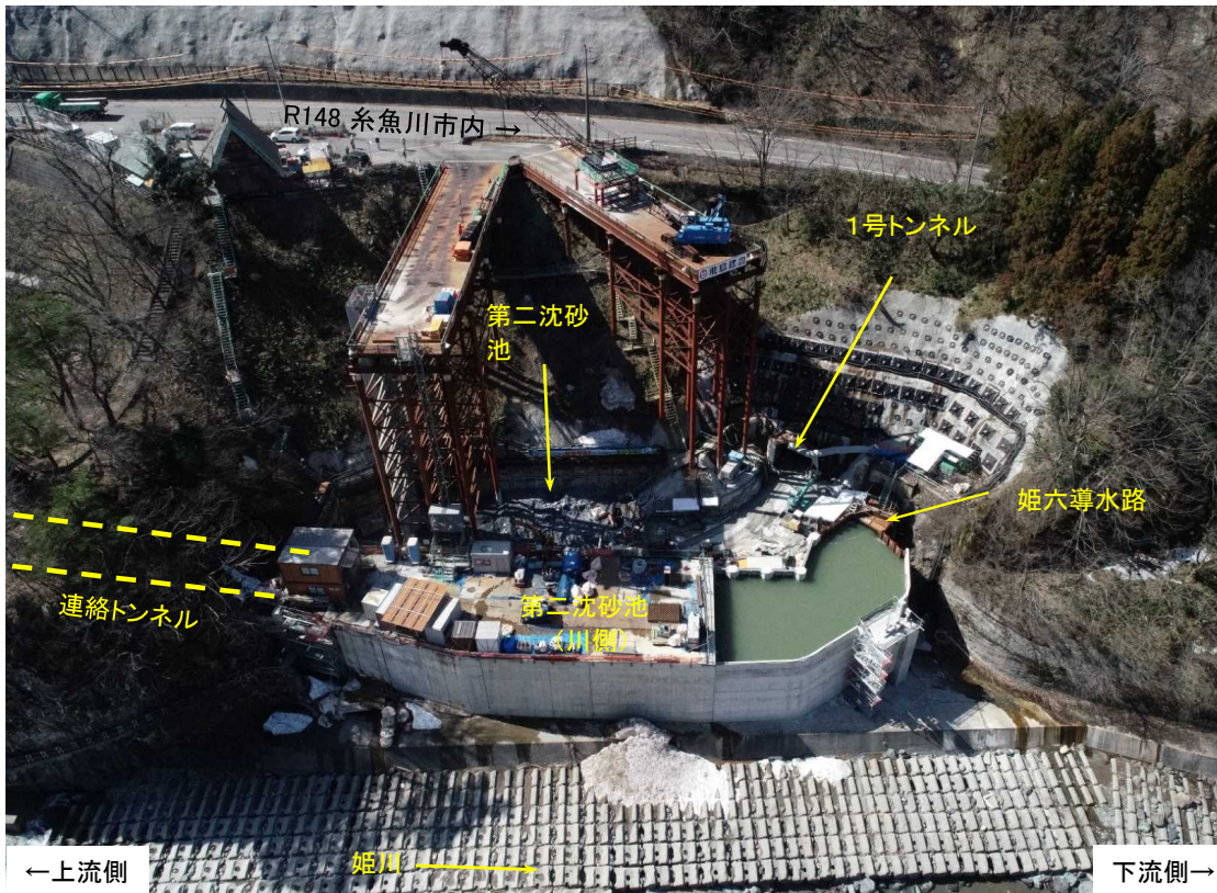
全景(川側より)
