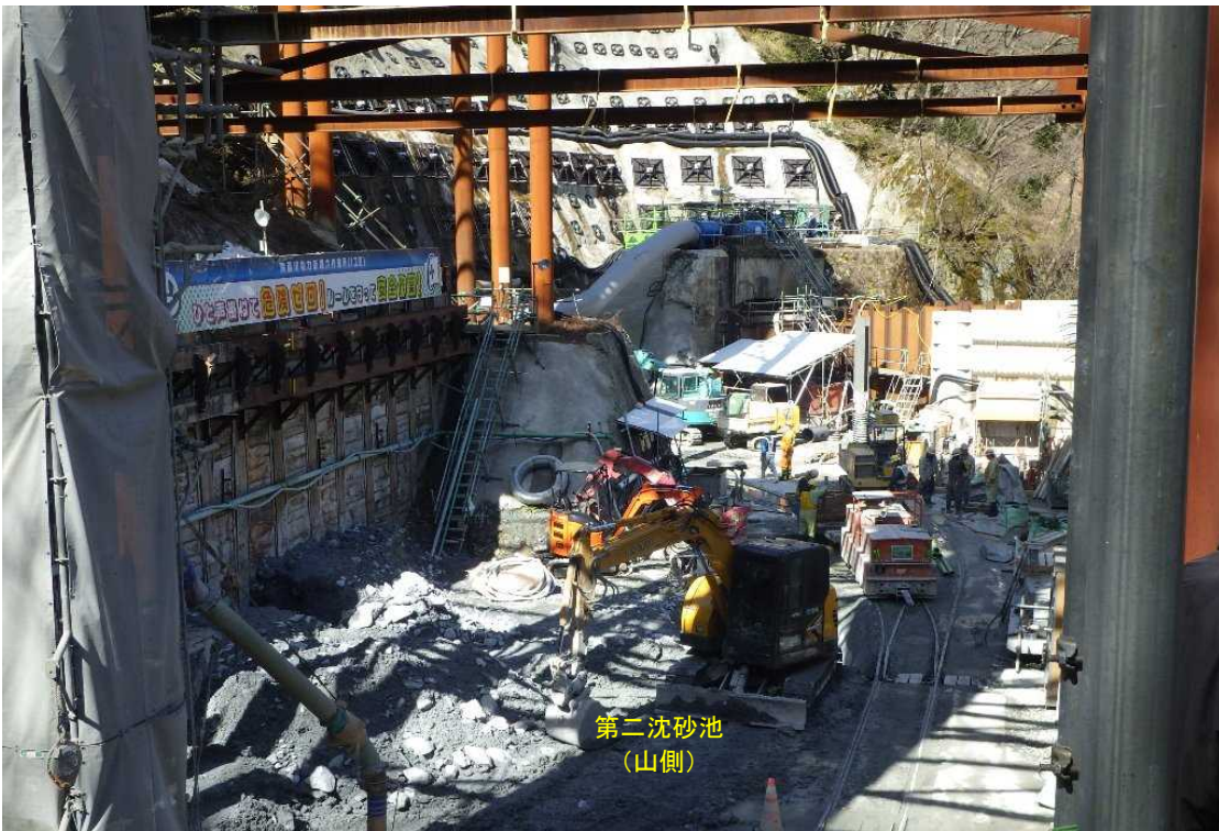
第二沈砂池(山側) 施工状況(上流より)
