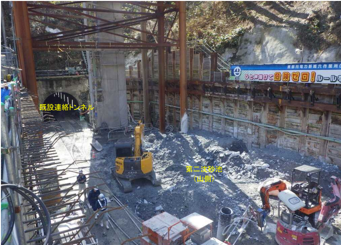
第二沈砂池(山側) 施工状況(下流より)
