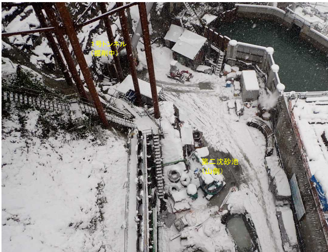
第二沈砂池(山側) 施工状況(上流より)
