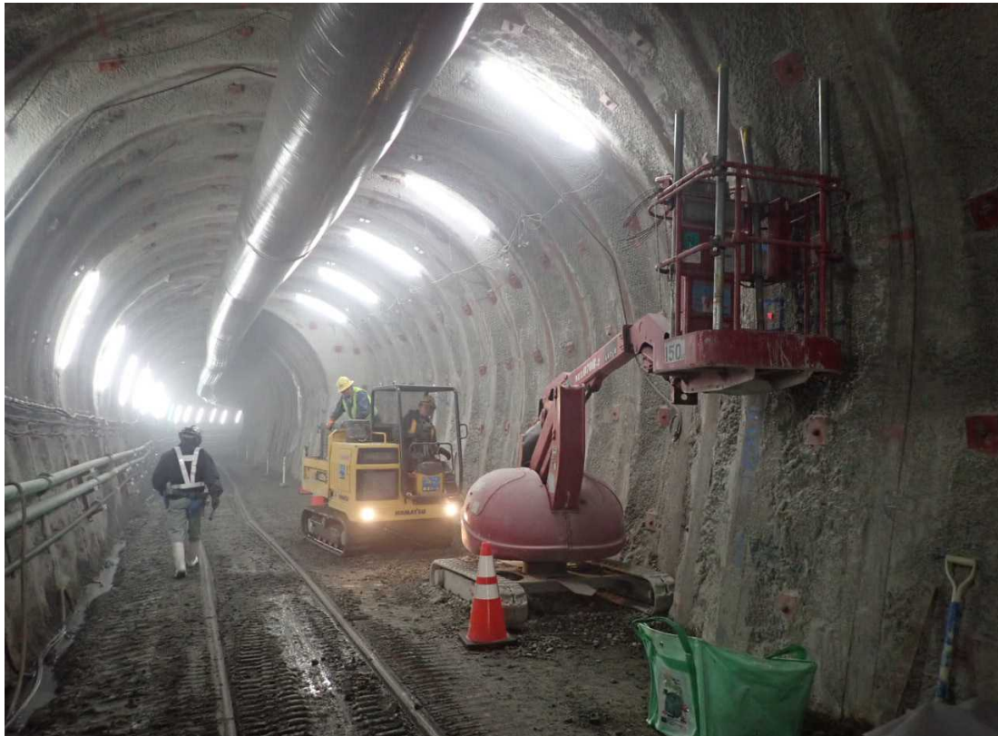
1号トンネル施工状況 (上流より)
