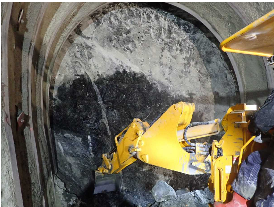
1号トンネル掘削状況 (上流より)
