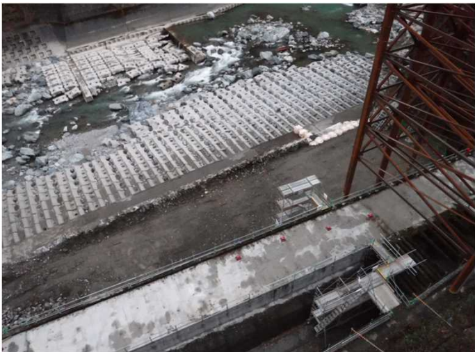
第二沈砂池川側掘削状況（下流より） （H30.12.21撮影）
