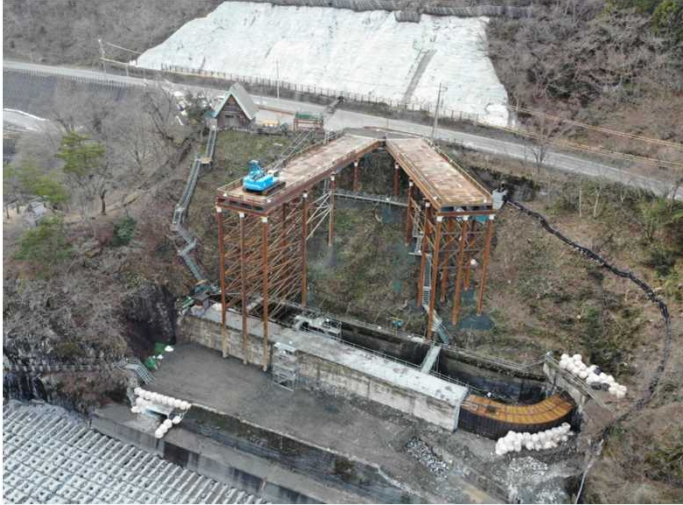
全景（川側より） （H30.12.21撮影）
