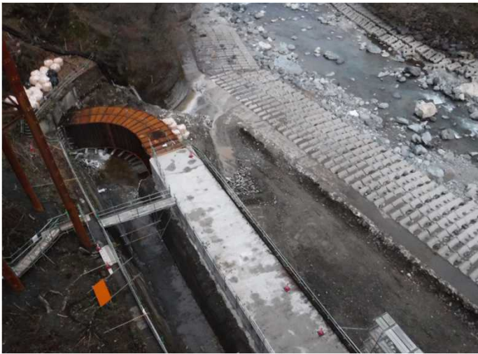
第二沈砂池川側掘削状況（上流より） （H30.12.21撮影）
