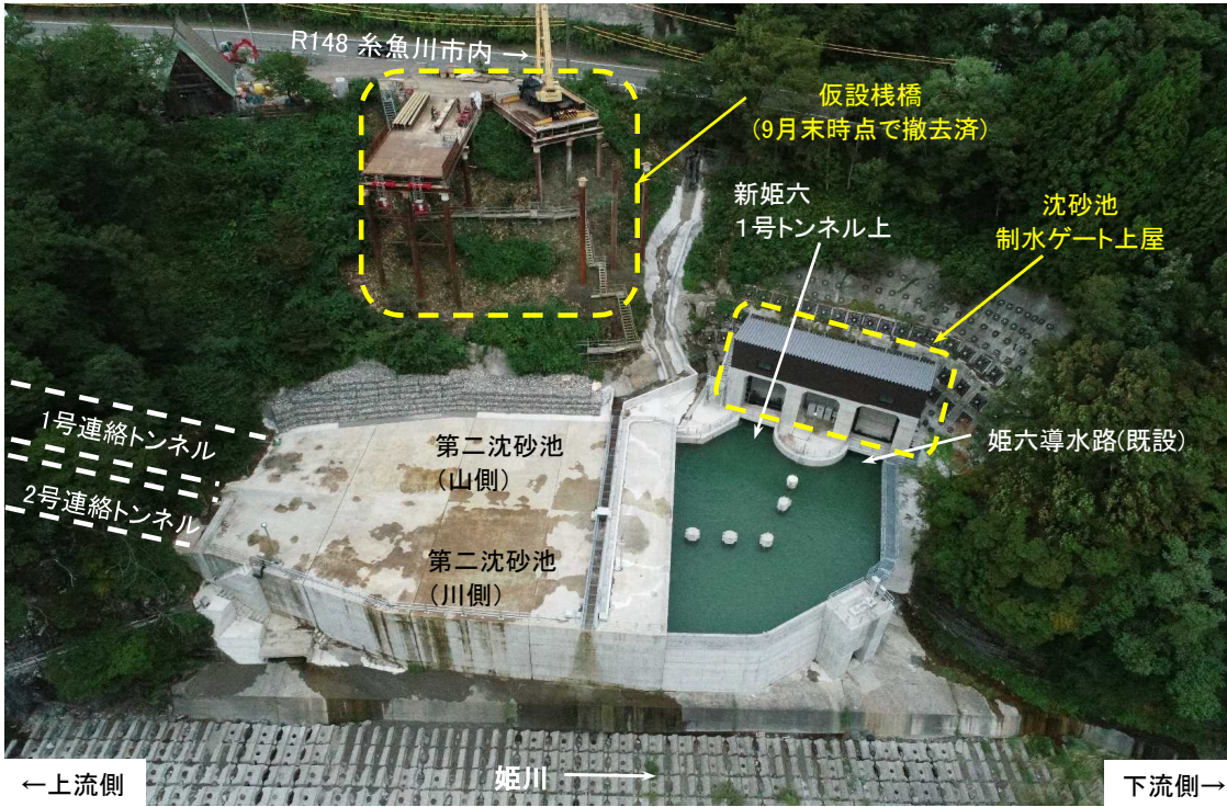
全景(川側より)
