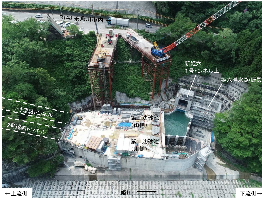
全景(川側より)
