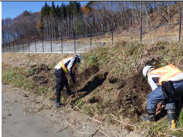
移植先の掘り込み (令和6年12月3日撮影)
