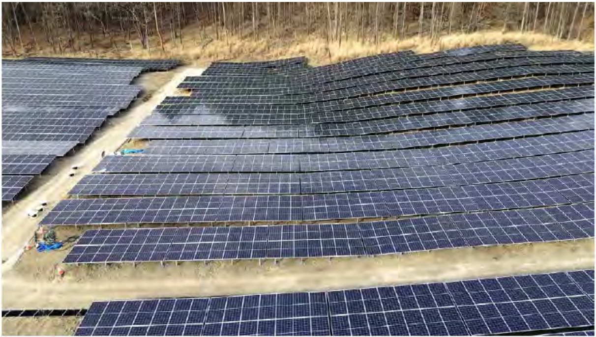
写真3-2(6) 工事の進捗状況写真 (⑧ No.8 調整池まわり : 令和6年12月31日時点)
