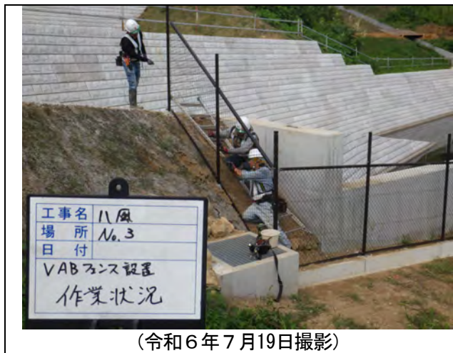
写真4-22：周辺環境との調和に配慮した色調としたフェンスの設置状況
