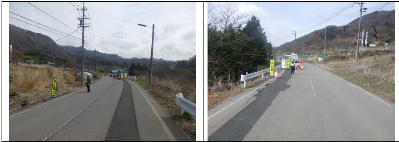
写真4-26：送電線の地下埋設工事状況（令和6年6月28日撮影）
