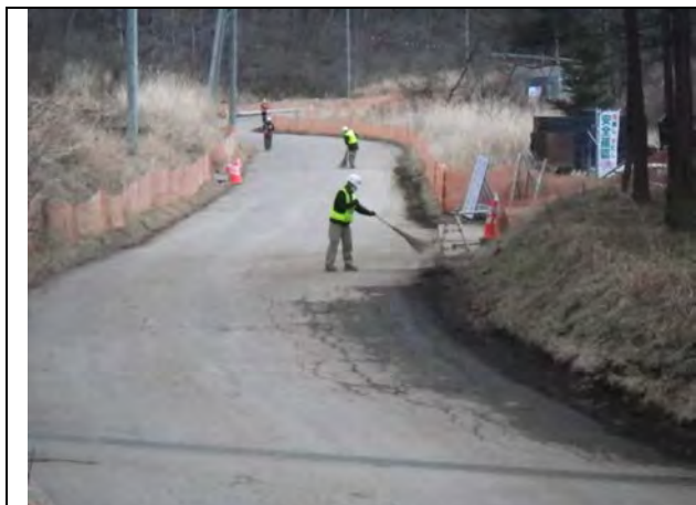
作業員による路面清掃状況 (令和6年2月19日撮影)
