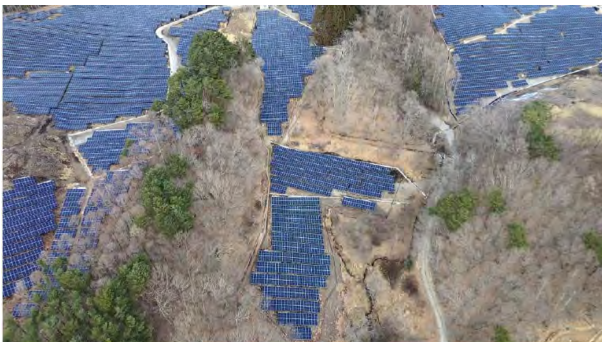
写真3-2(2) 工事の進捗状況写真 (④ No.4 調整池まわり : 令和6年12月31日時点)
