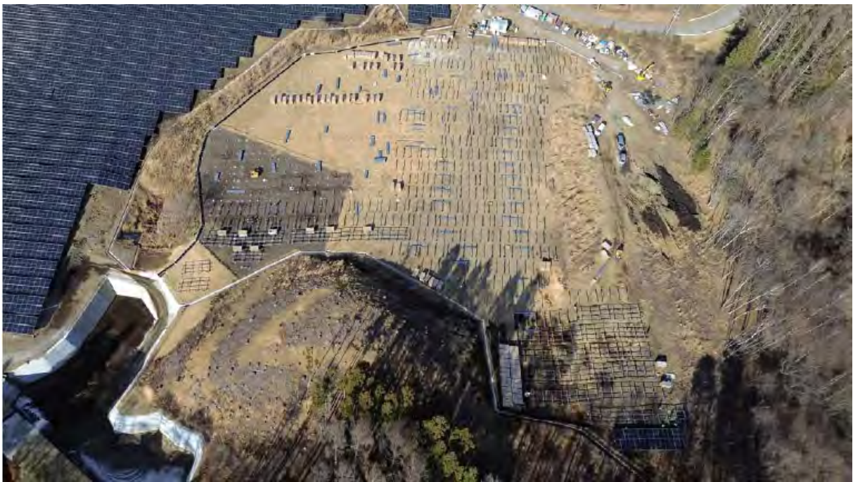
写真3-2(5) 工事の進捗状況写真 (⑦ No.7調整池まわり・チップヤード：令和6年12月31日時点)
