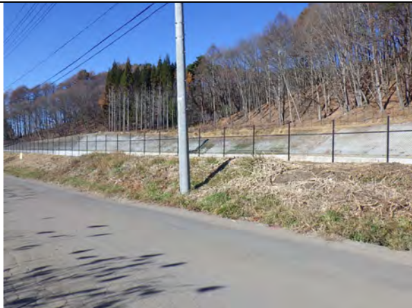
移植先とした路傍の法面 (令和6年12月3日撮影)
