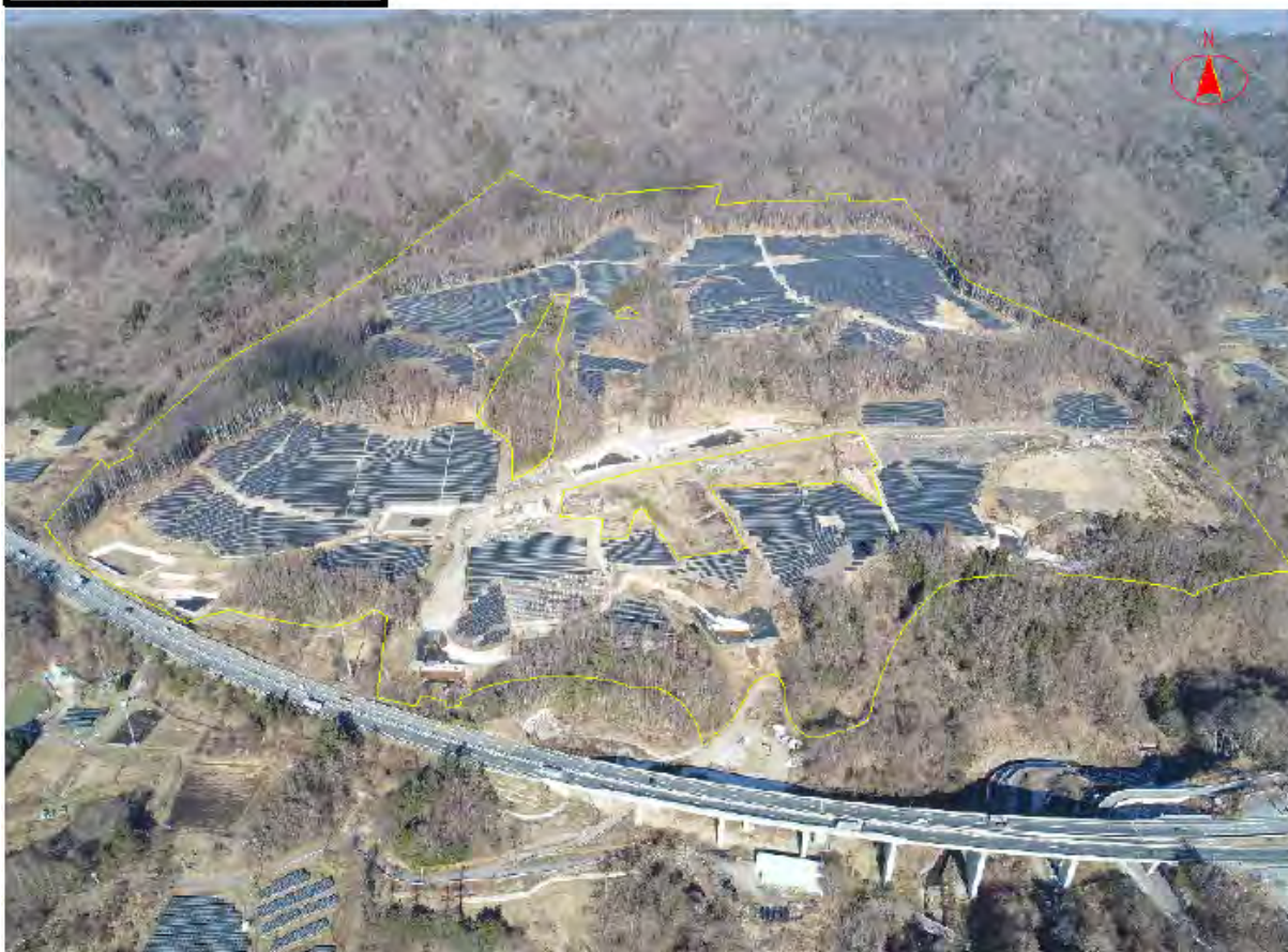
写真3-1 工事の進捗状況写真（全景：令和6年12月31日時点）
