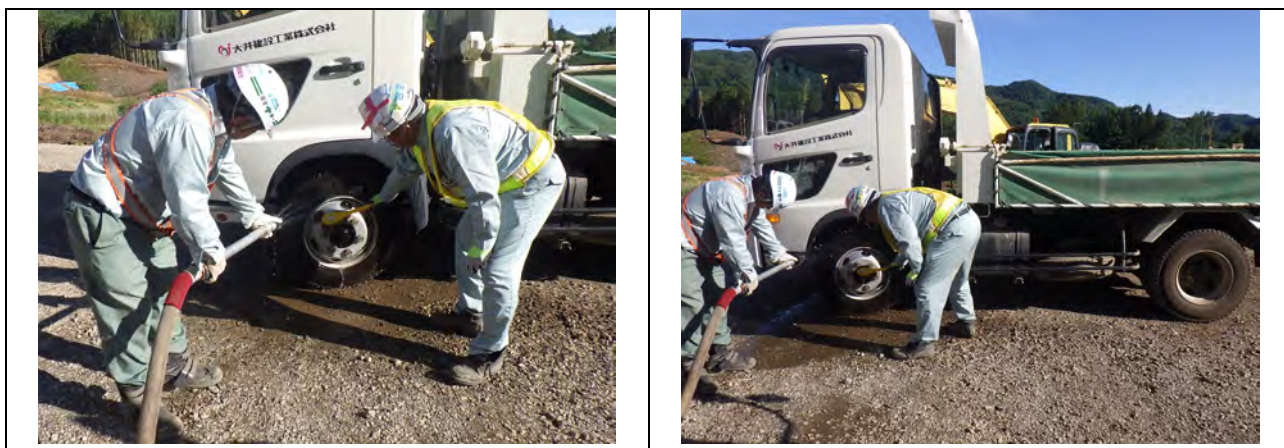
写真4-5：工事用車両のタイヤ洗浄状況（令和6年6月19日撮影）
