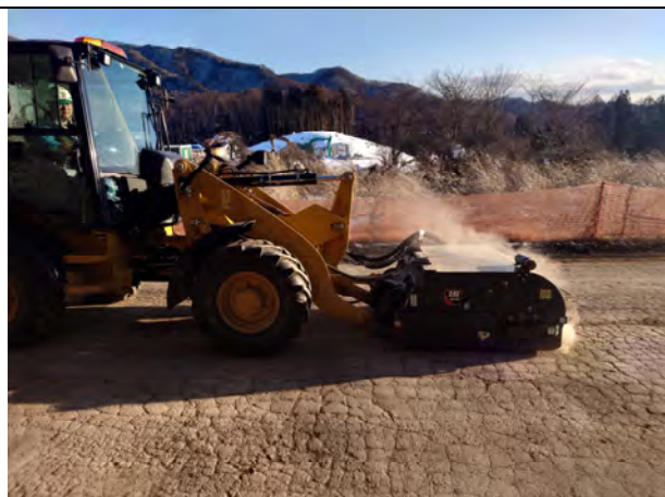
路面清掃機（スイーパー）による路面清掃状況 (令和6年3月13日撮影)
