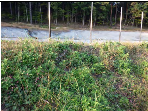
移植候補地とした路傍の法面の状況
