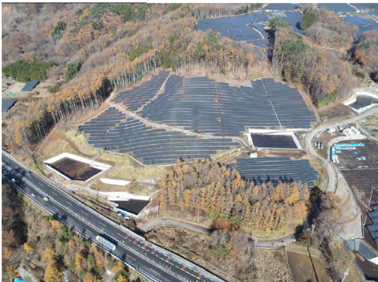
写真3-2(1) 工事の進捗状況写真（①②③ No.1、No.2、No.3調整池：令和6年11月30日時点）
