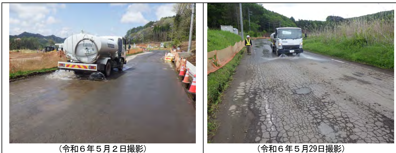
写真4-9：道路散水状況
