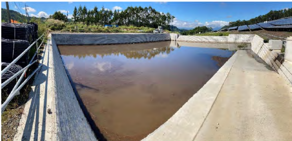
写真3-2(2) 工事の進捗状況写真 (② No.2 調整池まわり：令和6年9月30日時点)
