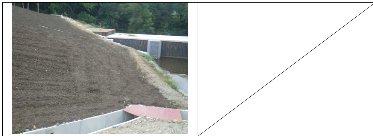
写真4-12：土面を平滑化し雨養生をした状況（令和6年9月27日撮影）
