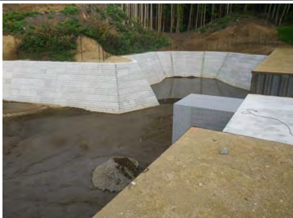
No. 7 調整池施工完了
