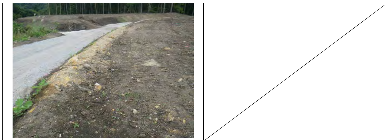
写真4-11：防災小堤（土堤）の設置状況（令和6年9月27日撮影）
