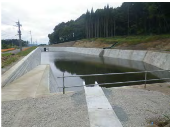
No. 4 調整池東側施工完了
