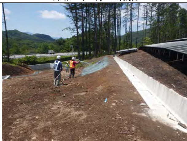
緑化工の実施状況 (令和6年6月5日撮影)
