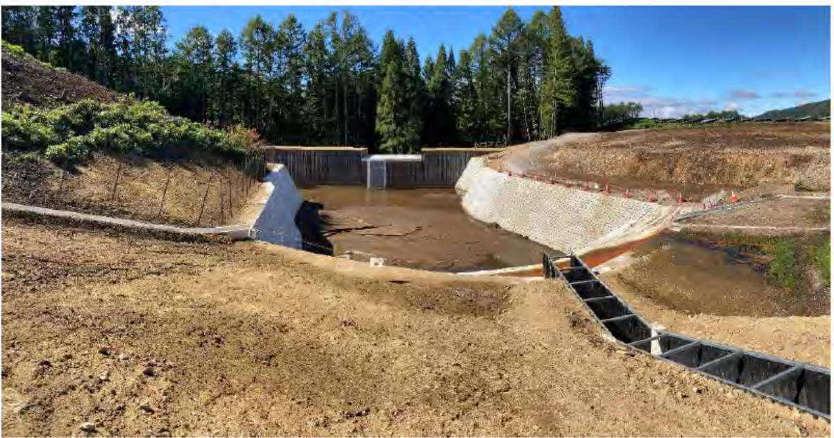
写真3-2(7) 工事の進捗状況写真 (⑦ No.7 調整池まわり・チップヤード：令和6年9月30日時点)
