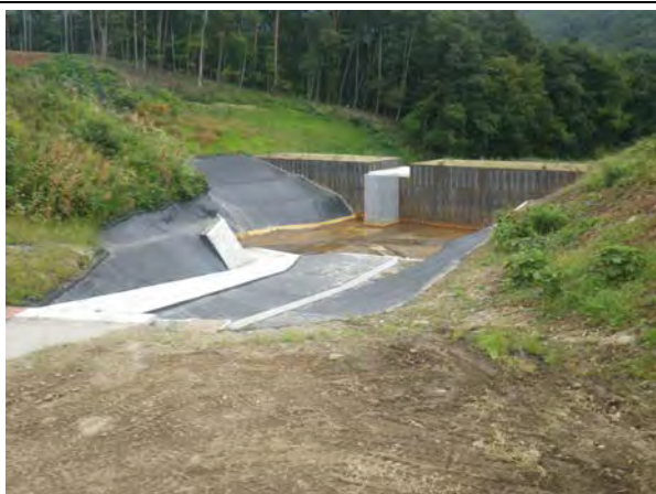
No. 6 調整池施工完了
