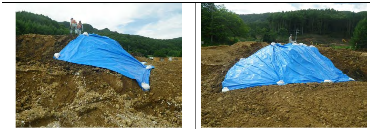
写真4-13：表土保全土のシート養生状況（令和5年6月29日撮影）
