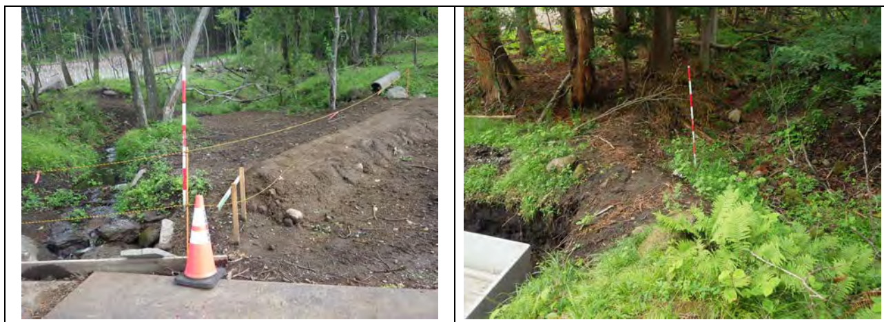
写真4-17：河道断面確保のため新設土堤防の設置状況（令和6年6月25日撮影）
