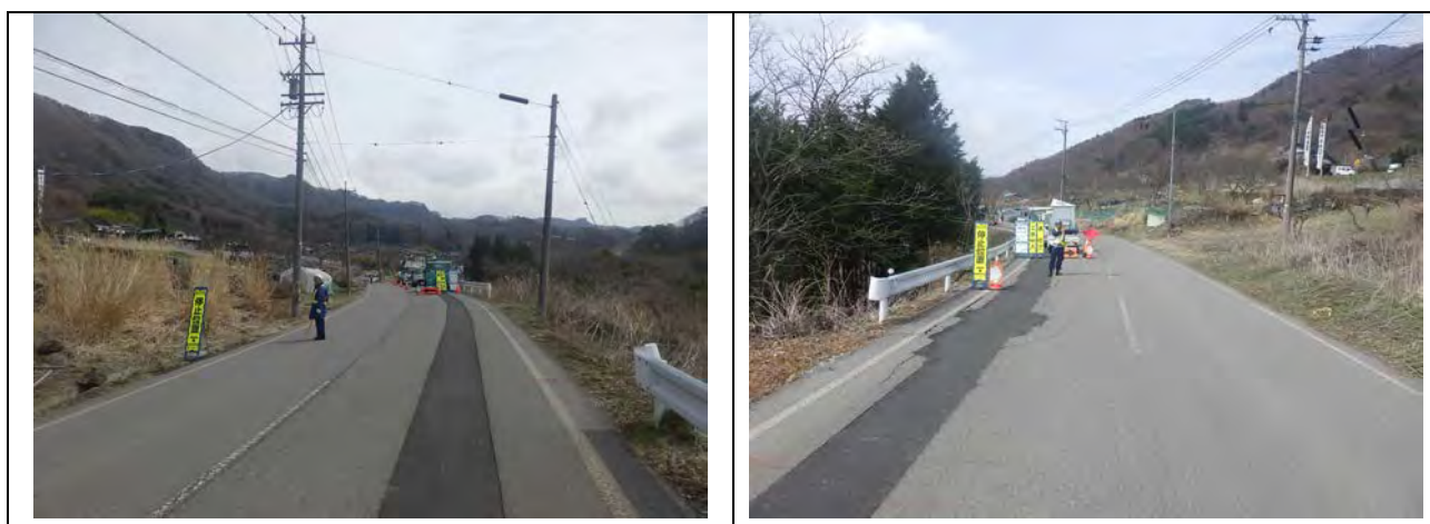
写真4-41：送電線の地下埋設工事状況（令和6年6月28日撮影）
