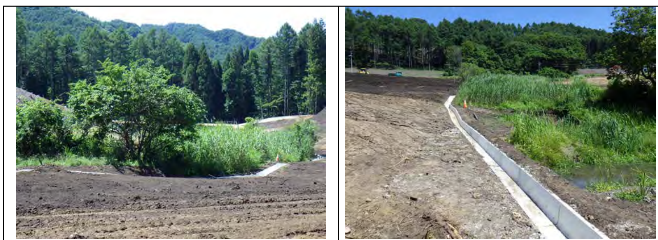
写真4-23：サクラソウ自生地への濁水流入防止対策としての排水路設置状況（令和6年8月1日撮影）
