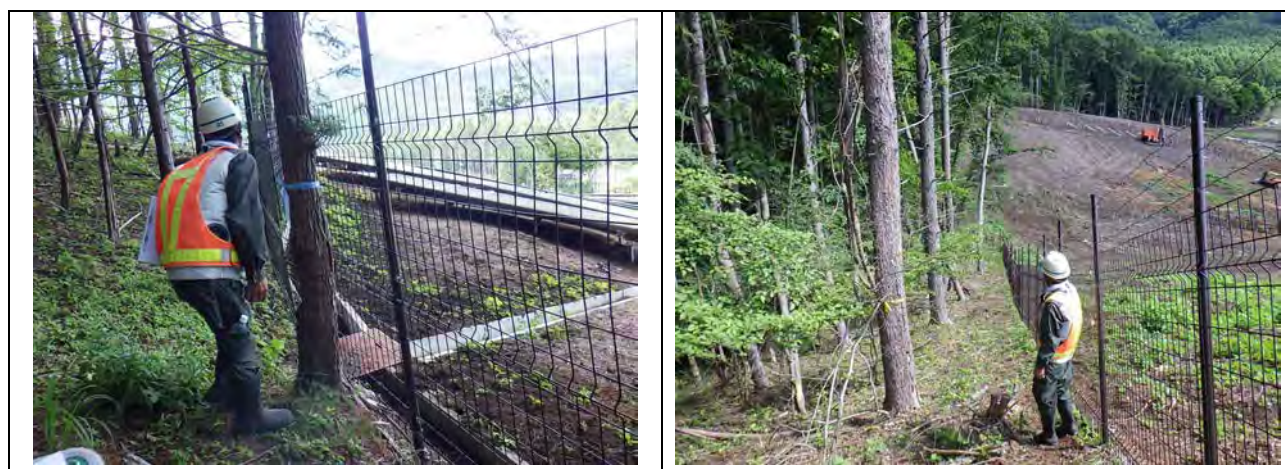
写真4-9：残置森林の危険木点検状況（令和6年7月23日撮影）
