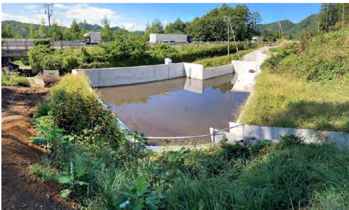
写真3-2(3) 工事の進捗状況写真 (③ No.3 調整池まわり：令和6年9月30日時点)
