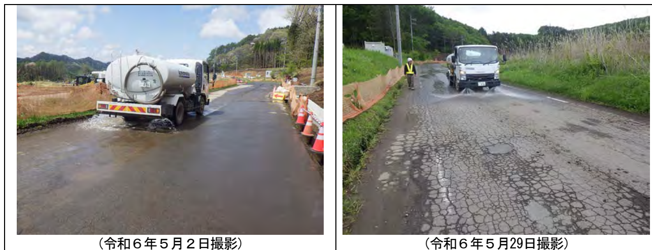
写真4-8：道路散水状況
