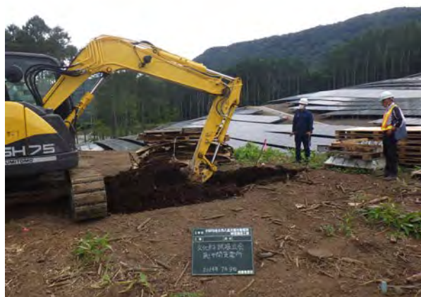
第2中間変電所
