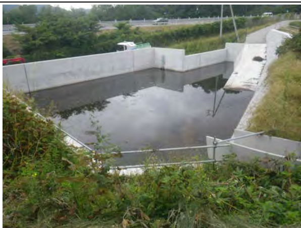
No. 3 調整池施工完了
