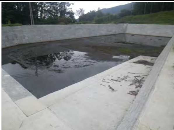
No. 1 調整池施工完了
