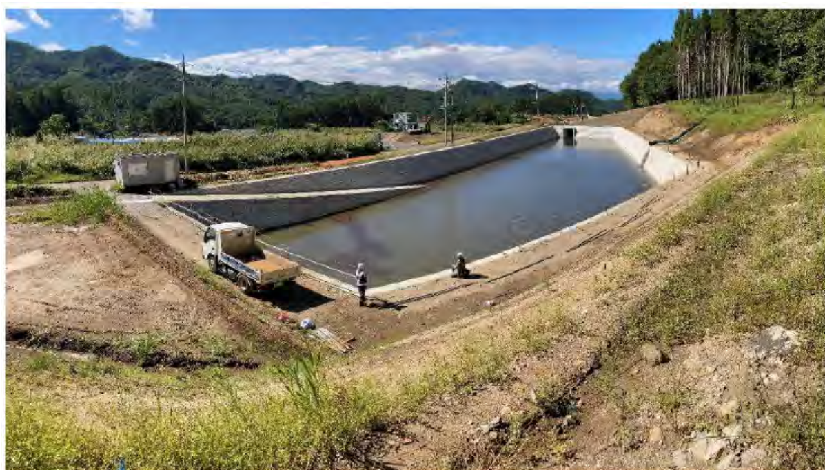
写真3-2(4) 工事の進捗状況写真 (④ No.4 調整池まわり：令和6年9月30日時点)
