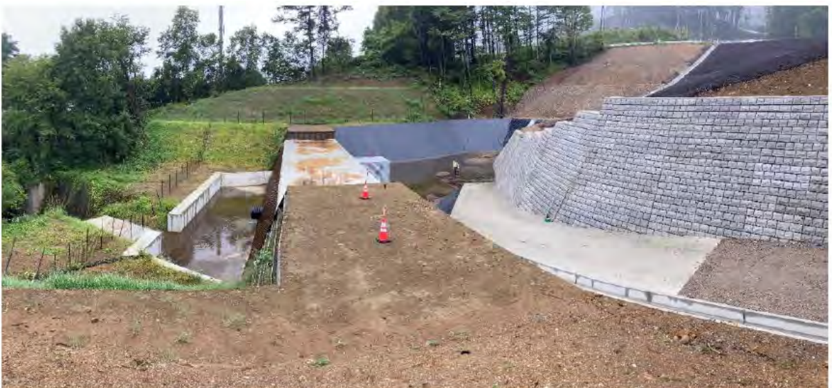
写真3-2(5) 工事の進捗状況写真 (⑤ No.5 調整池まわり・土仮置き場：令和6年9月30日時点)
