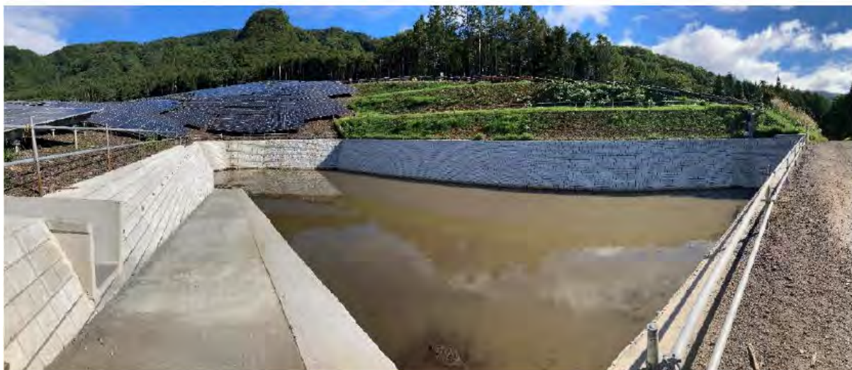
写真3-2(8) 工事の進捗状況写真 (⑧ No.8 調整池まわり：令和6年9月30日時点)
