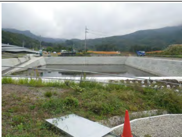
No. 2 調整池施工完了
