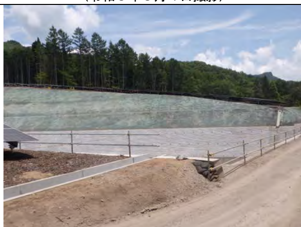
緑化工の実施状況 (令和6年6月7日撮影)
