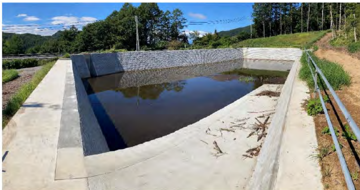
写真3-2(1) 工事の進捗状況写真（① No.1調整池まわり：令和6年9月30日時点）
