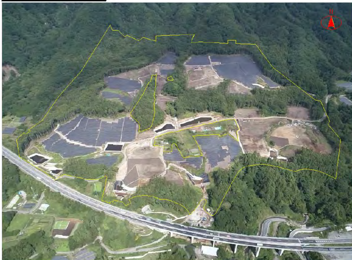
写真3-1 工事の進捗状況写真（全景：令和6年9月30日時点）
