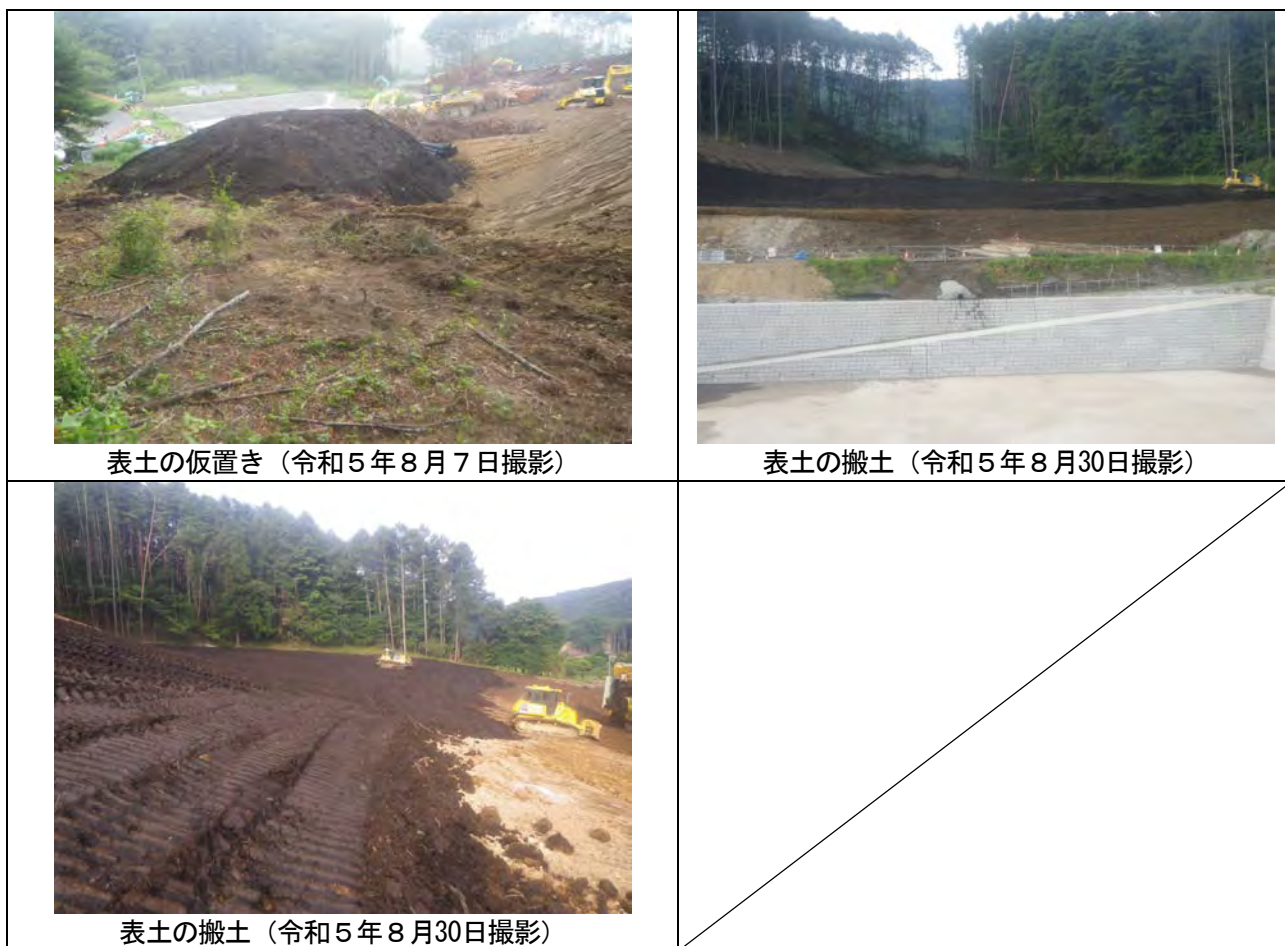
写真4-34：造成地における表土の剥ぎ取り・仮置き・搬土状況
