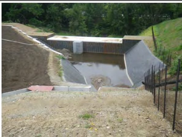
No. 5 調整池施工完了
