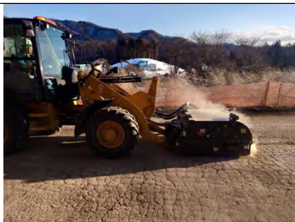
路面清掃機（スィーパー）による路面清掃状況 (令和6年3月13日撮影)
