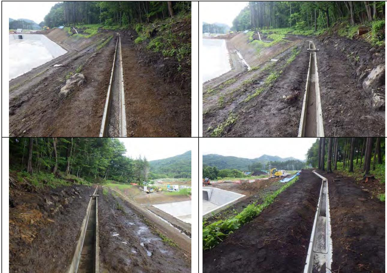
写真4-12：防災小堤（土堤）の設置状況
