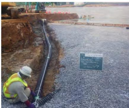
写真6.4-1 底版下の暗渠排水の敷設状況写真
