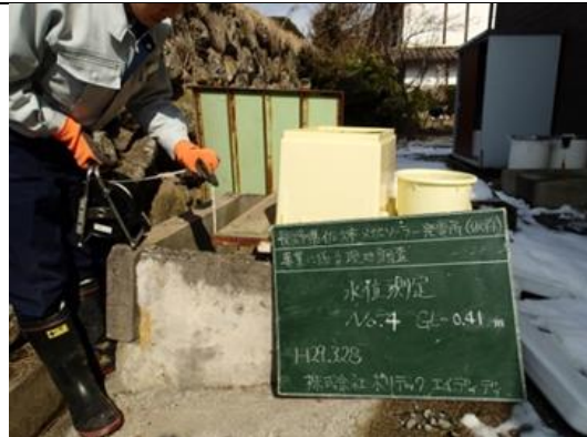
既存井戸の水位調査(水位測定器)
