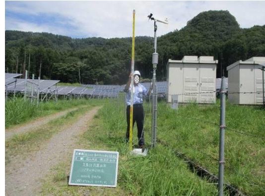
気温・湿度・風向・風速 (太陽光パネル設置場所の中央付近)
