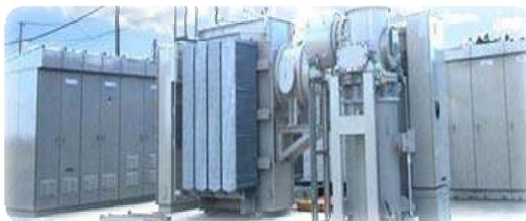
写真1.5-5 二次変圧設備（イメージ）
