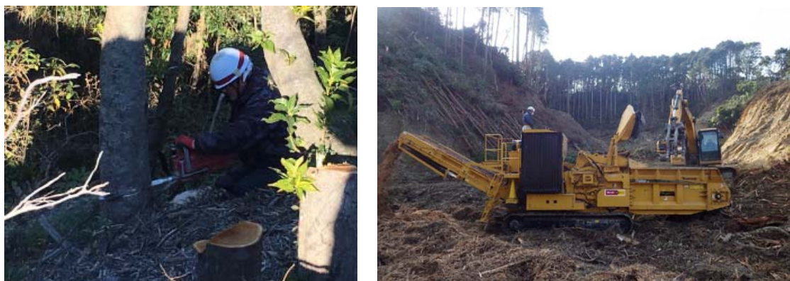
写真1.5-6 伐採工事のイメージ
