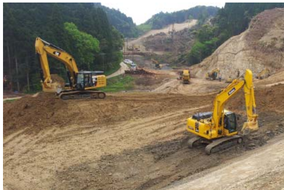
写真1.5-7 造成工事のイメージ
