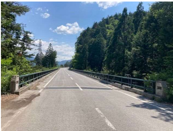
写真 5.5.1.3 わらび沢大橋
