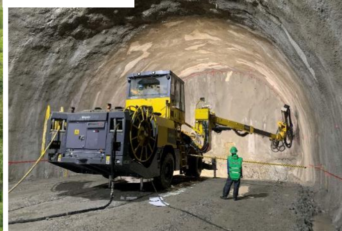
本坑掘削状況
