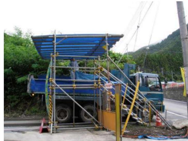
写真④ 防塵シートの設置
