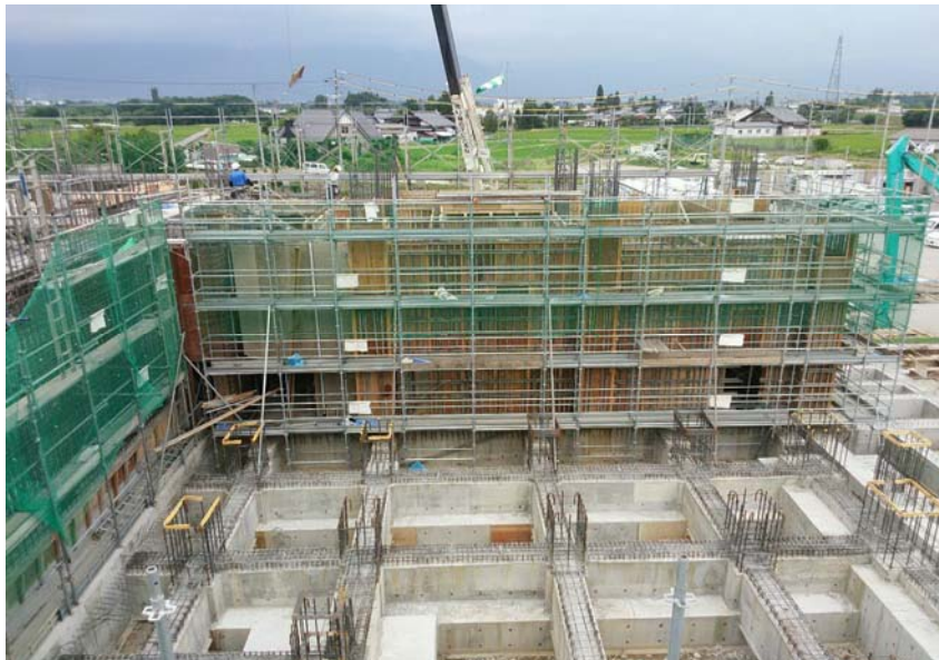
工場棟 躯体工事
