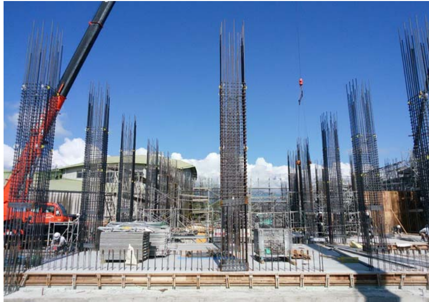
工場棟 躯体工事
