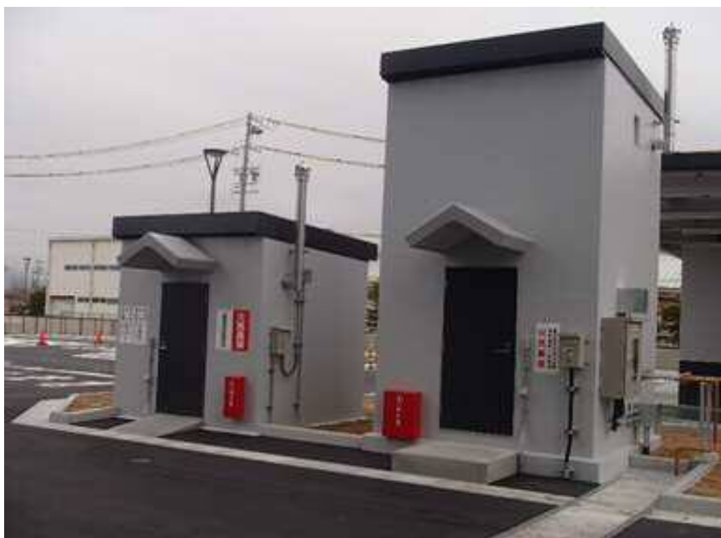
1月 助燃油ポンプ室・油脂庫 建築工事
