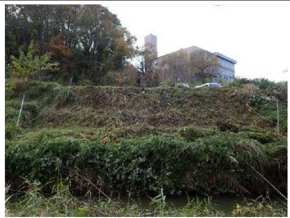
写真 3.1.96 除草作業後の状況(11月)
