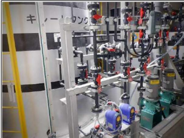
写真 3. 12. 3 安定化剤注入装置の様子
