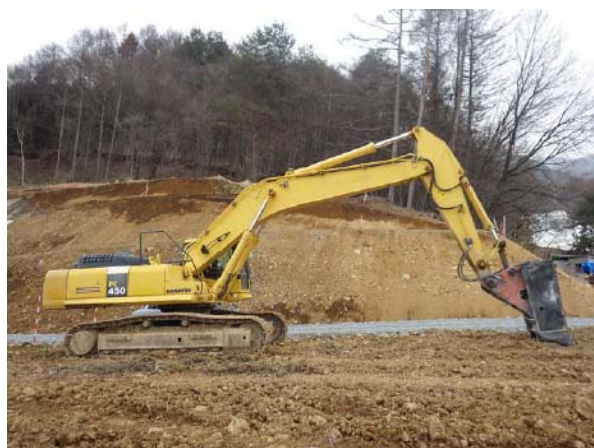
写真 4.2.6 大型ブレーカ用防音カバーの装着
