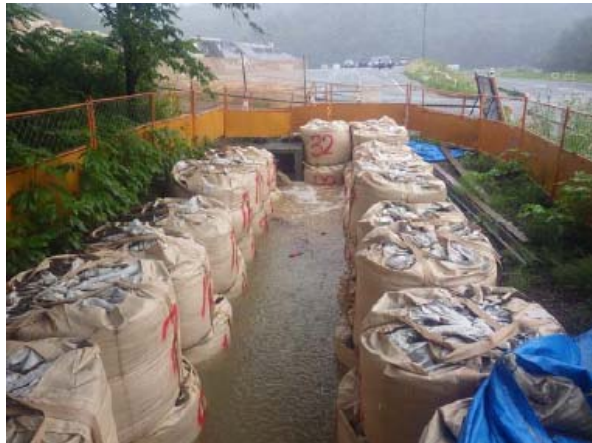
写真 4.4.7 雨水排水の濁りの監視
