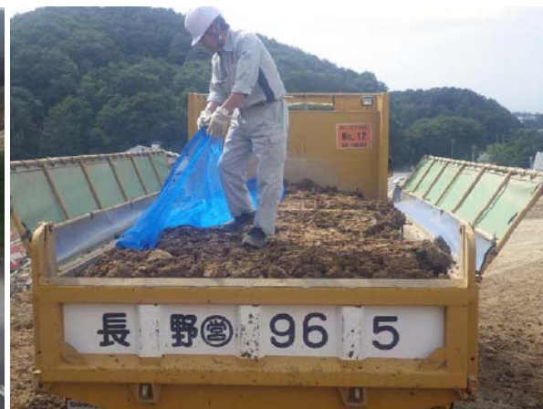
写真 4.1.4 荷台シート養生
