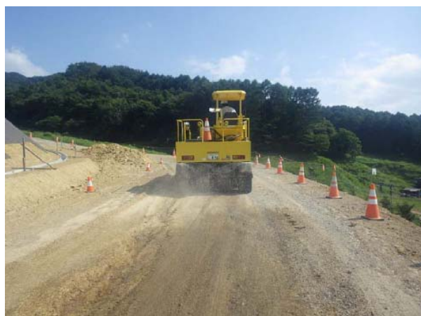
写真 4.1.7 構内道路散水実施状況
