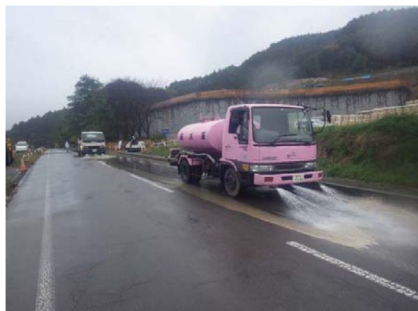
写真 4.1.3 路面散水状況
