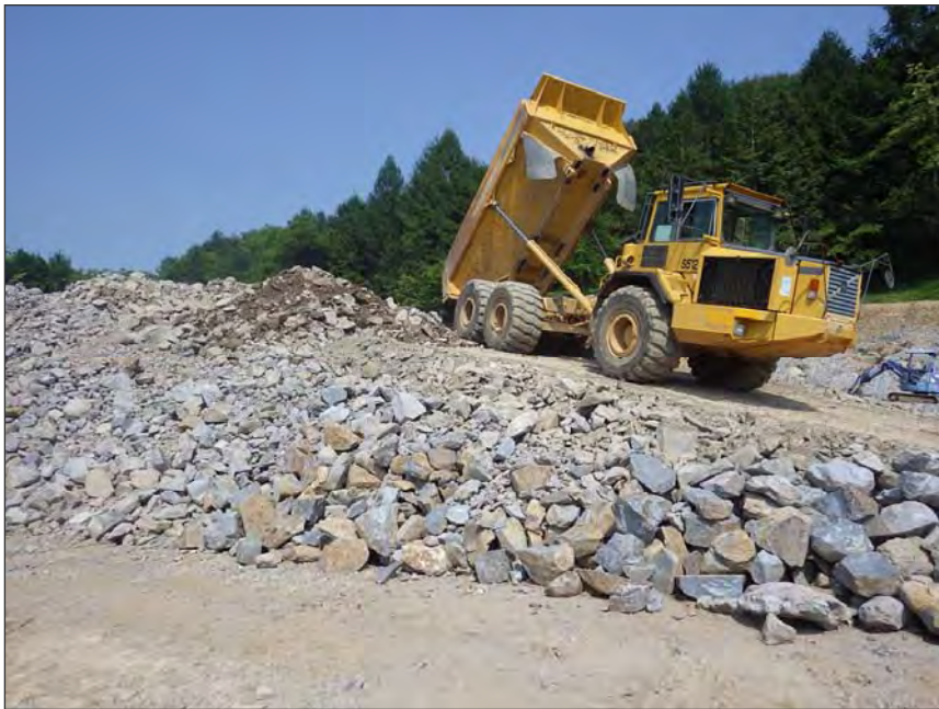
写真区分:環境対策 工種:転石・岩 現場盛土材 再利用 写真タイトル:場内運搬荷降 ろし状況 撮影箇所:現場内
