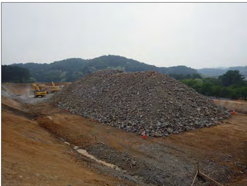
写真区分:環境対策 工種:転石・岩 現場盛土材 再利用 写真タイトル:場内仮置き状 況 撮影箇所:現場内
