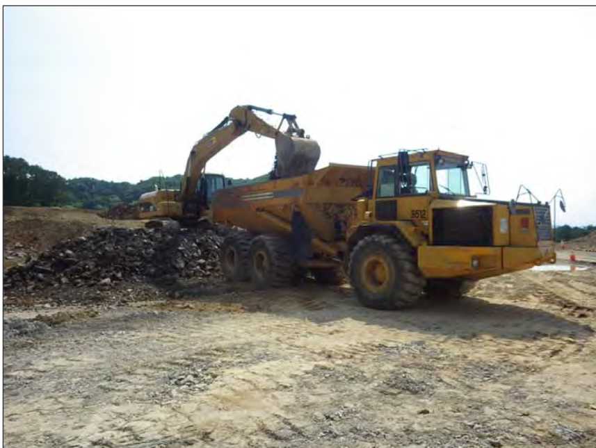
写真区分:環境対策 工種:転石・岩 現場盛土材 再利用 写真タイトル:岩碎積込状況 撮影箇所:P. 15
