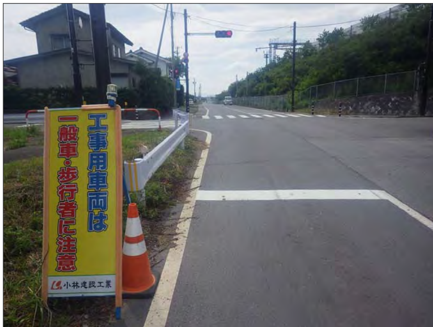
写真区分:環境対策 工種:交通規制の遵守・エコ ドライブの励行 写真タイトル:看板設置状況 撮影箇所:高速道路側道
