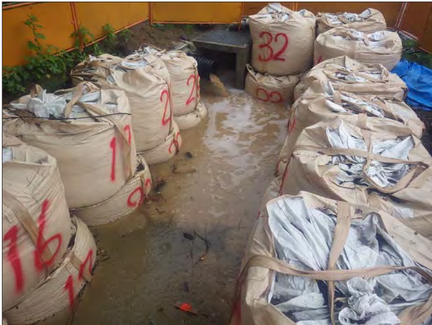
写真区分:環境対策 工種:沈砂池等の設置 写真タイトル:雨水排水の濁りの監視 撮影箇所:補強土壁部沈砂池
