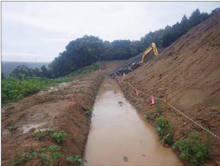
写真区分:環境対策 工種:土側溝の設置 写真タイトル:場内排水の処 理状況 撮影箇所:場内
