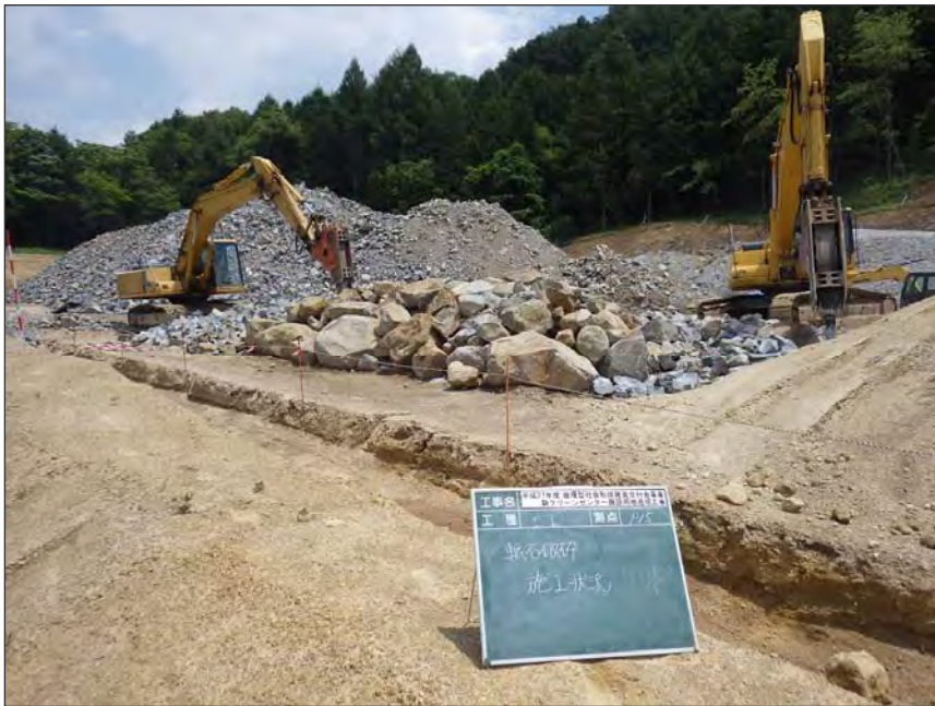
写真区分:環境対策 工種:転石・岩 現場盛土材 再利用 写真タイトル:転石破碎状況 撮影箇所:P. 15
