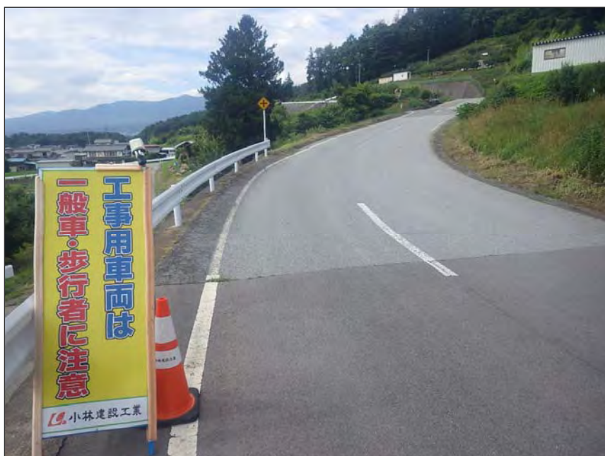
写真区分:環境対策 工種:交通規制の遵守・エコ ドライブの励行 写真タイトル:看板設置状況 撮影箇所:南北線
