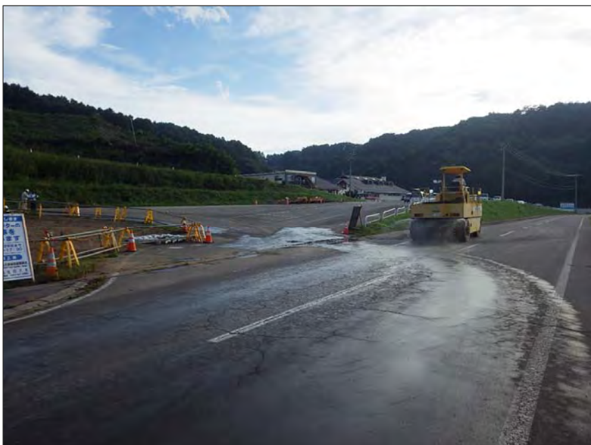
写真区分:環境対策 工種:工事区域への散水等 写真タイトル:散水実施状況 撮影箇所:工事区域
