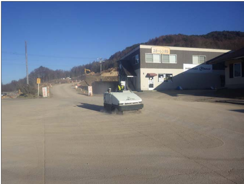
写真区分:環境対策 工種:工事用車両出入口の路面洗淨 写真タイトル:路面清掃車使用状況 撮影箇所:工事車両出入口
