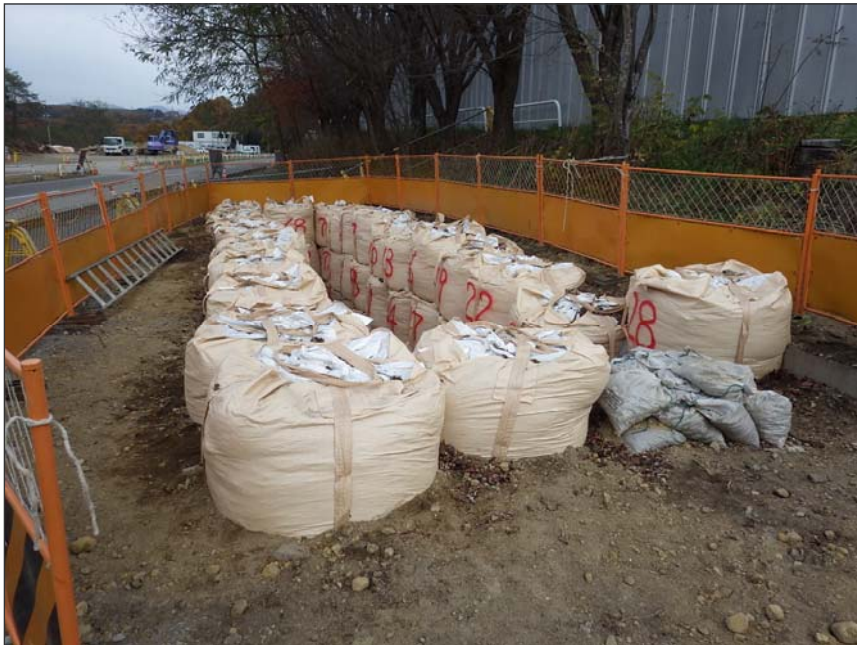
写真区分:環境対策 工種:工事区域内からの流出抑制 写真タイトル:仮設沈砂池設置状況 撮影箇所:20号集水桝横
