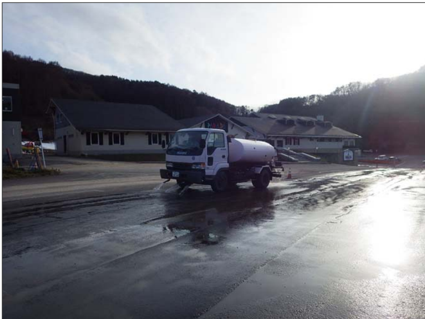
写真区分:環境対策 工種:工事用車両出入口の路面洗淨 写真タイトル:路面散水状況 撮影箇所:工事車両出入口
