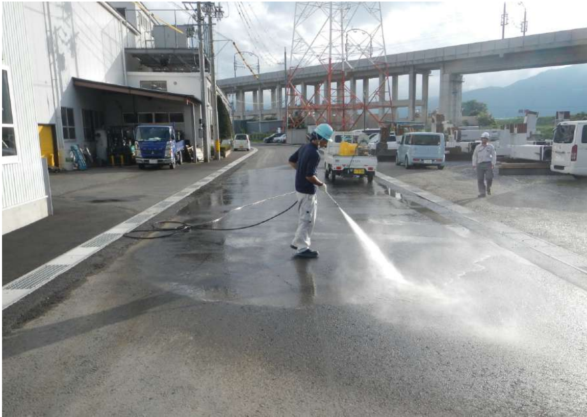
散水機による路面洗浄
