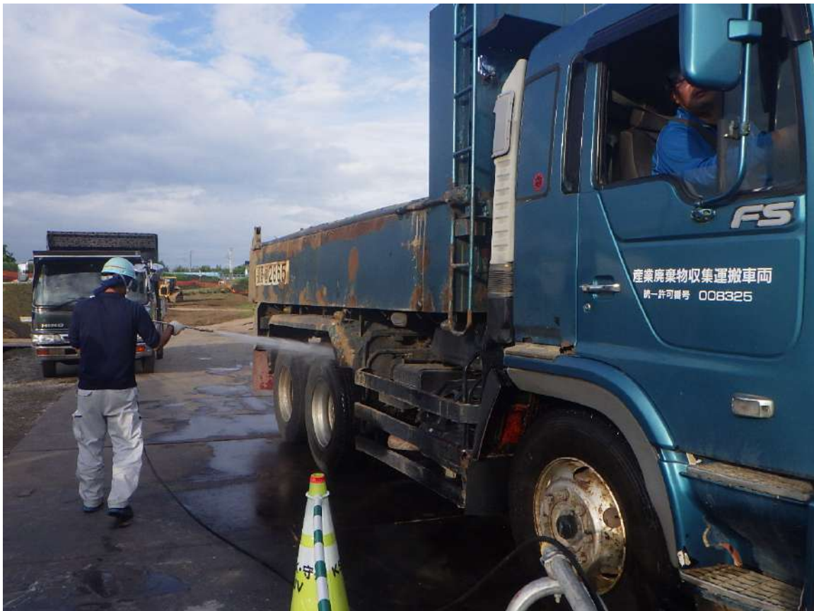
散水機によるタイヤ洗浄
