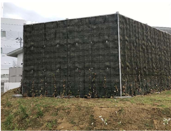
体験学習棟（千曲市余熱利用施設）
