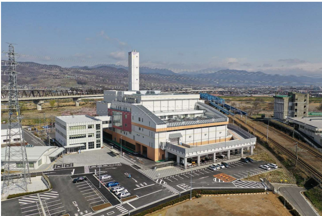
施設南側より撮影 (右側：工場棟、左側：管理棟)
