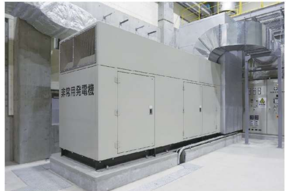
非常用発電機
