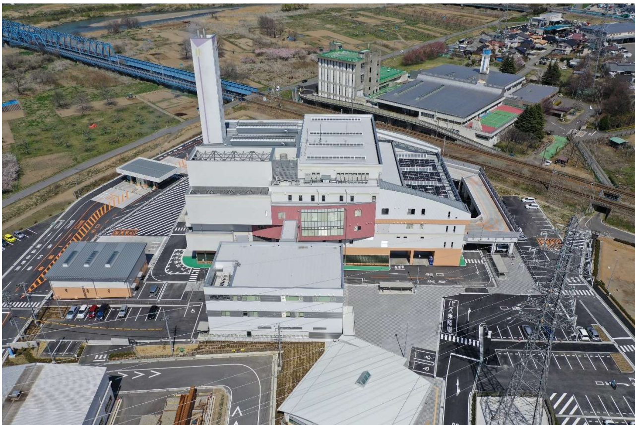
施設南西側より撮影 (左奥：計量棟、左手前：洗車棟、奥：工場棟、手前：管理棟)
