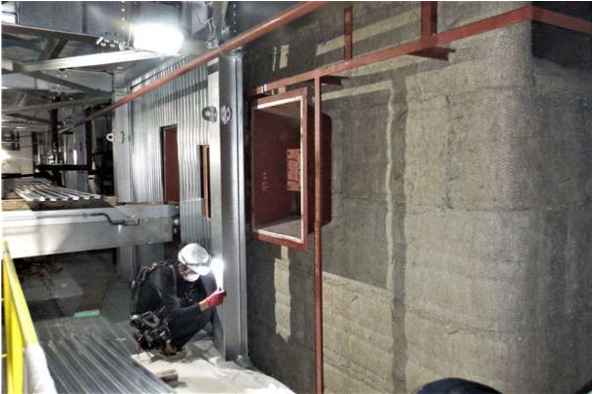
・焼却炉耐火物工事(C工区)
