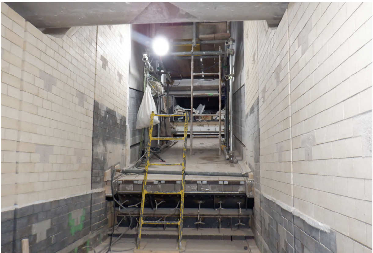
・焼却炉耐火物工事(C工区)
