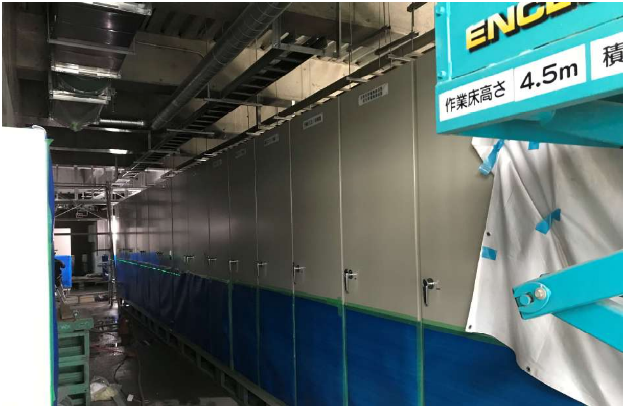
・焼却炉・ボイラー設置状況(C工区)
