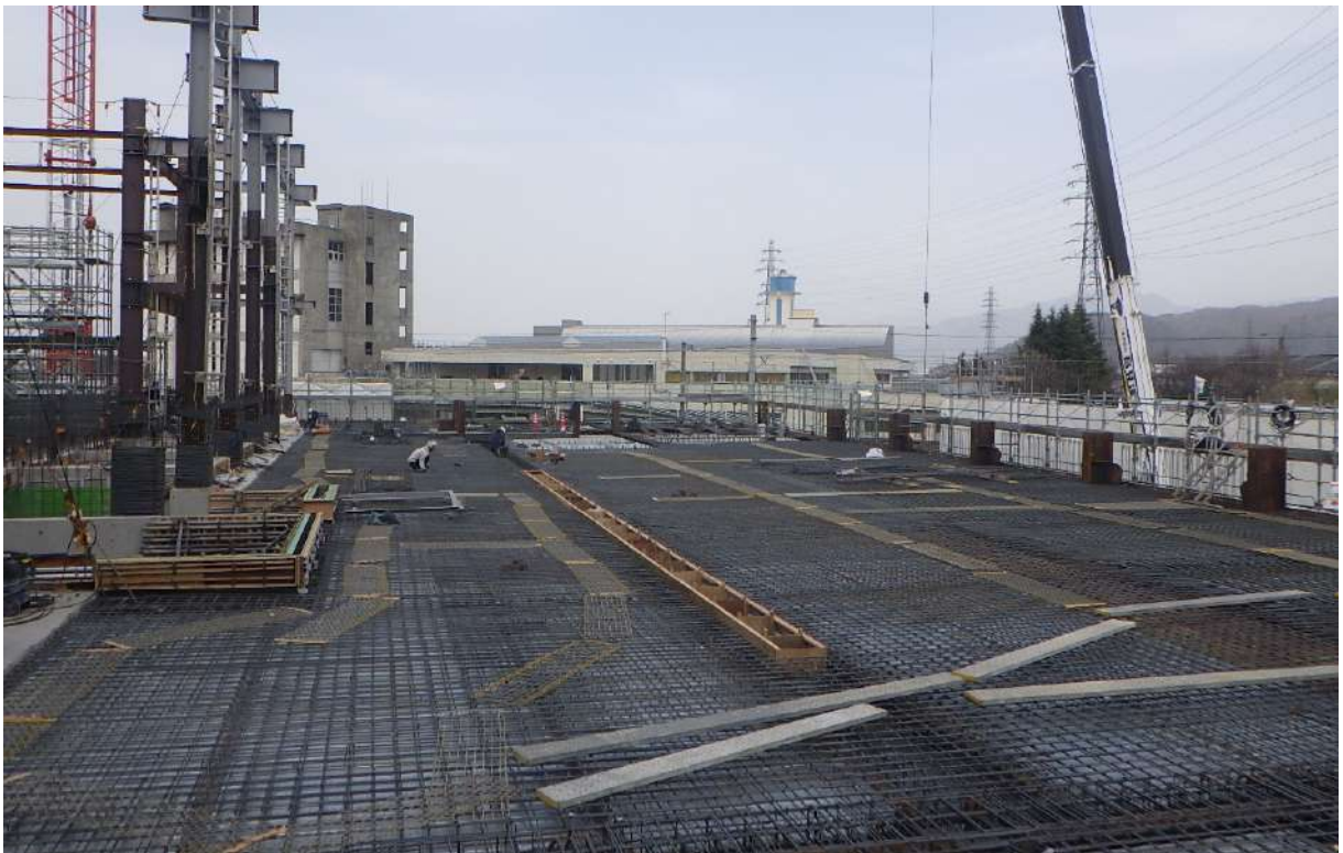
・配筋工事(A 工区 2 階)
