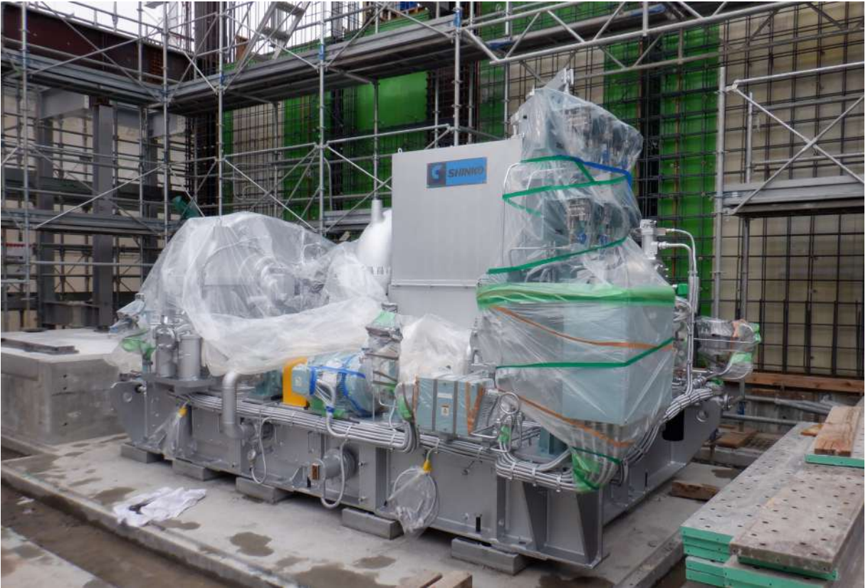
・ タービン発電機設置(C 工区)
