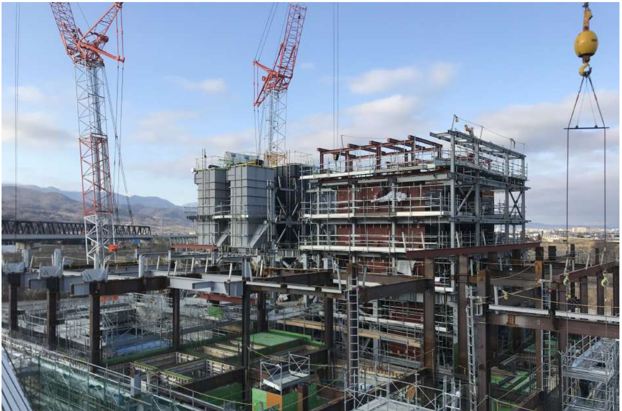
・ボイラー・集じん装置設置状況(C工区)
