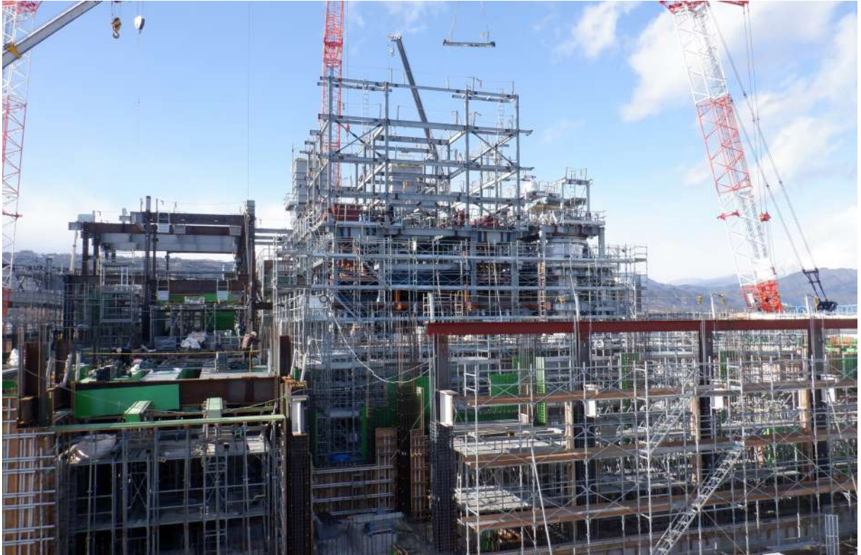
・ボイラー・集じん装置設置状況(C工区)
