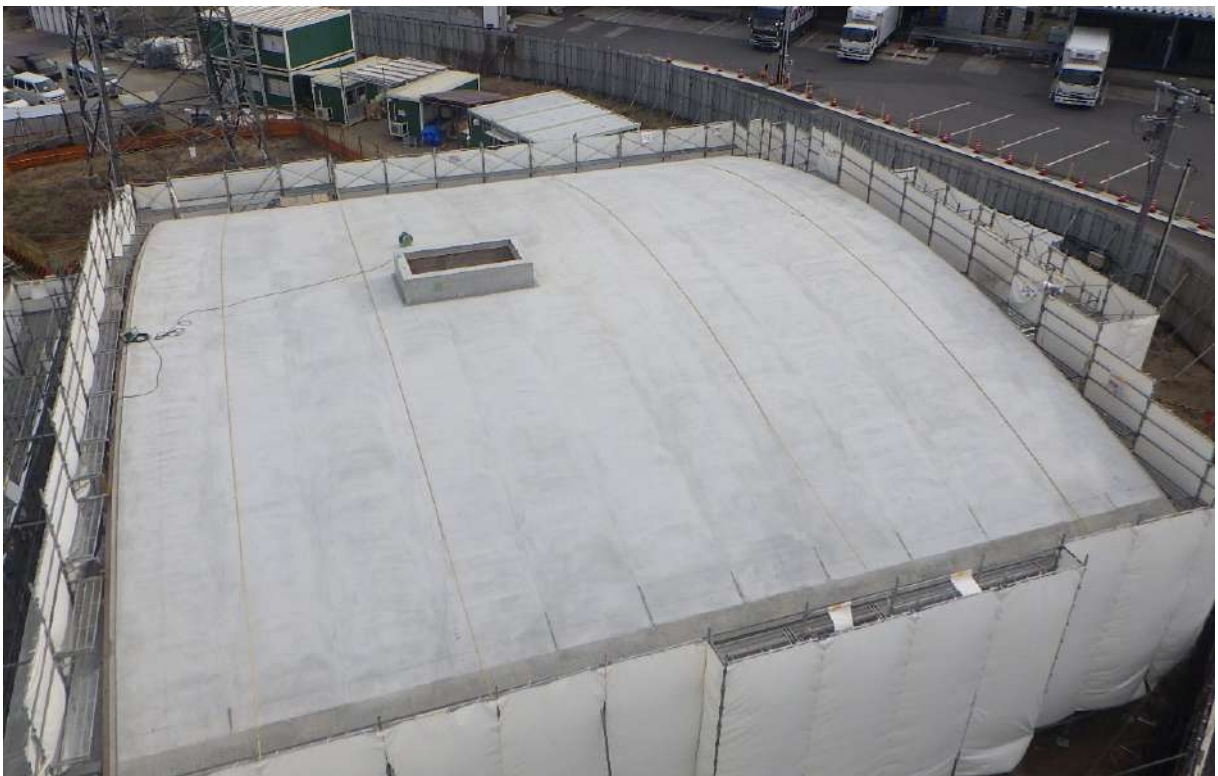
・ コンクリート打設後(体験学習棟)
