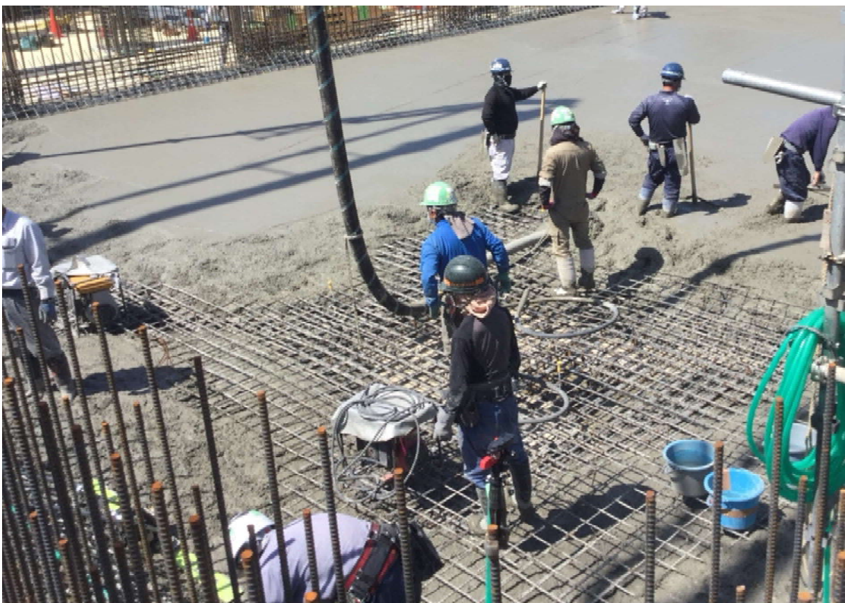
・ごみピットコンクリート打設状況②
