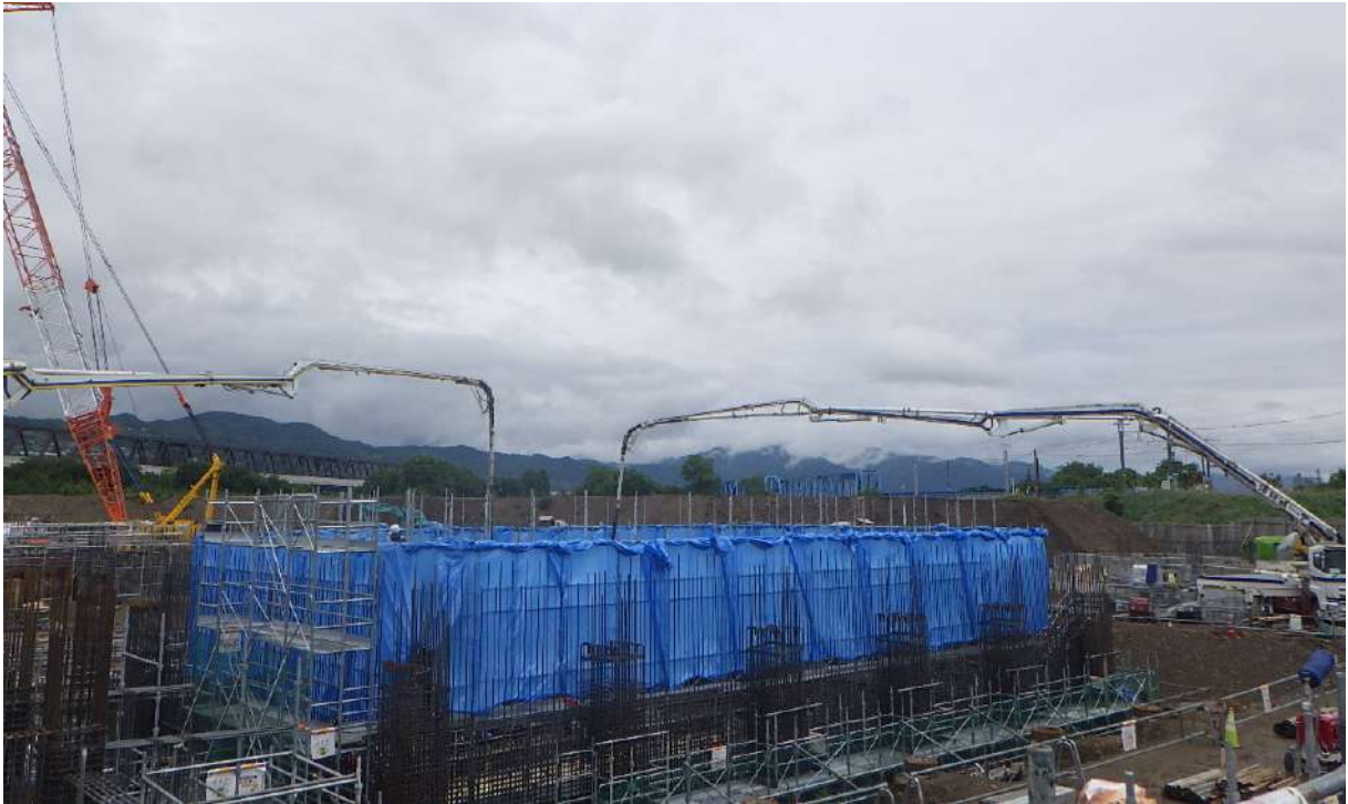
・ごみピットコンクリート打設状況②
